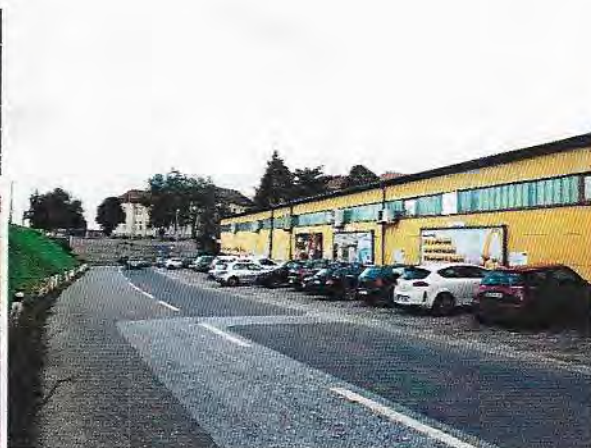
Foto 2: Anton-Kleinoscheg-Straße: Blick Richtung Süden zur Ibererestraße, Rechts das Planungsge- biet – Baufeld III
