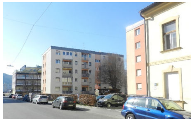
Abbildung 14: Blick entlang der Bauernfeldstraße Höhe Hausnummer 32 in Richtung Nordosten
