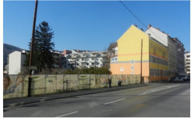
Abbildung 8: Kreuzung Karl-Morre-Straße/Bauernfeldstraße Blick Richtung Nordwesten
