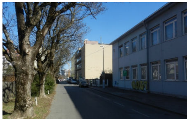
Abbildung 10: Blick entlang der Königshoferstraße Höhe Hausnummer 33 in Richtung Osten
