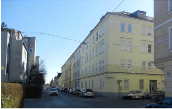
Abbildung 11: Blick auf die Bebauung Gaswerkstraße 44 in Richtung Südwesten
