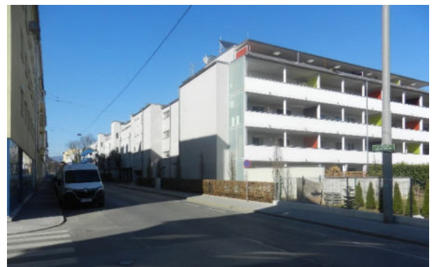
Abbildung 6: Kreuzung Gaswerkstraße/Bauernfeldstraße Blick Richtung Nordosten
