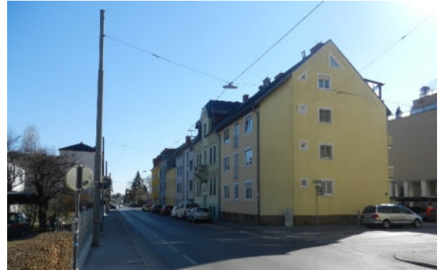
Abbildung 4: Kreuzung Bauernfeldstraße/Gaswerkstraße Blick Richtung Südwesten
