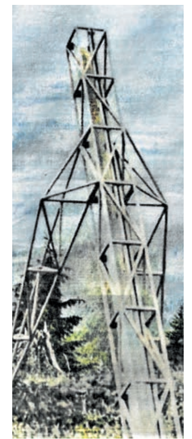
Die Startrampe am Schöckl. Die 6,5 m lange Konstruktion wurde in Teilen mühevoll auf den Berg getragen.
