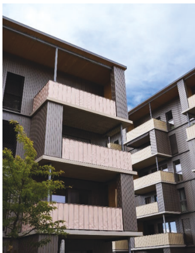
Abbildung 21: Übertragungswohnbau Ziehererstraße in Holzbauweise © short&sweet
