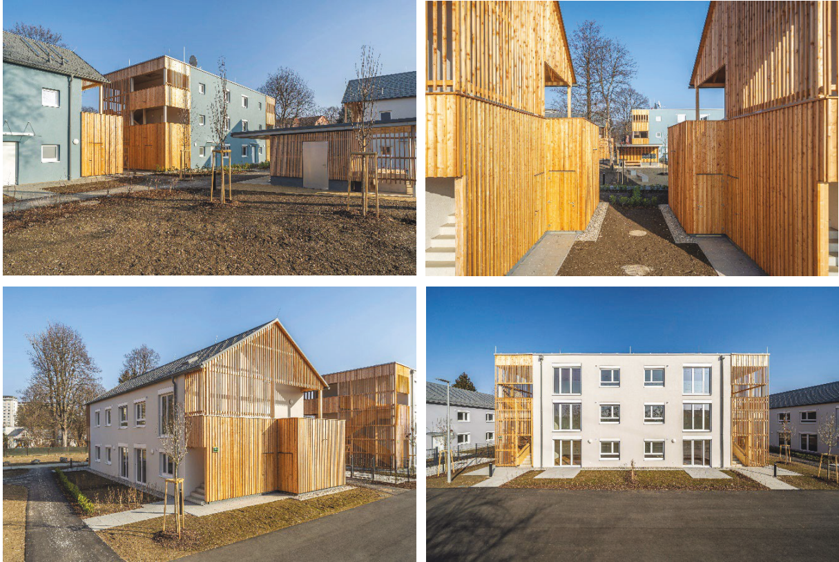
Abbildung 15-18: Das zweite Eigenneubauprojekt des Eigenbetriebes Wohnen Graz © Foto Fischer
