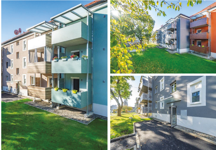
Abbildung 23-25: Thermische Sanierung mit Balkonanbau in der Triester-Siedlung © Foto Fischer
