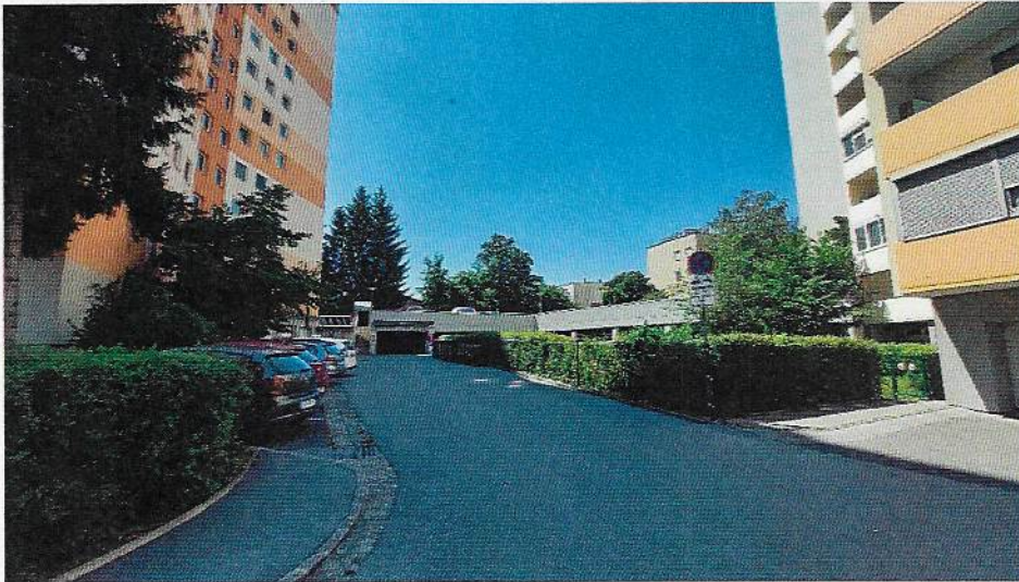
Foto 10: Blick in nordwestliche Richtung an der Mariengasse 56, im Südosten des Bebauungsplangebiets.
