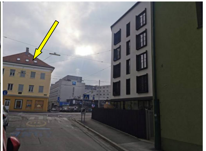
Foto 25: Blick in südöstliche Richtung von der Neubaugasse auf die Keplerstraße mit der Bebauung der Liegenschaft Keplerstraße 5 (siehe Pfeil), rechts ist ein Gebäude jüngeren Datums (Keplerstraße 14) im Bild zu sehen
