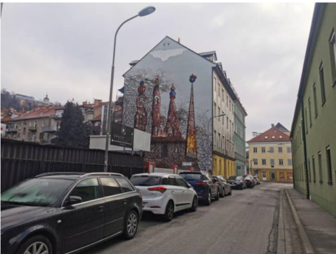
Foto 24: Blick in südöstliche Richtung auf das viergeschossige Gebäude in der Neubaugasse 22
