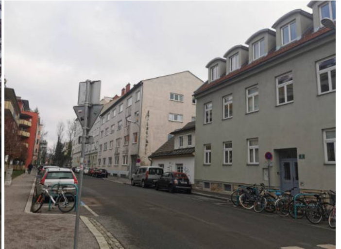
Foto 17: Blick in östliche Richtung in die Netzgasse, rechts im Bild ist die Bebauung der Liegenschaft Netzgasse 2 zu sehen
