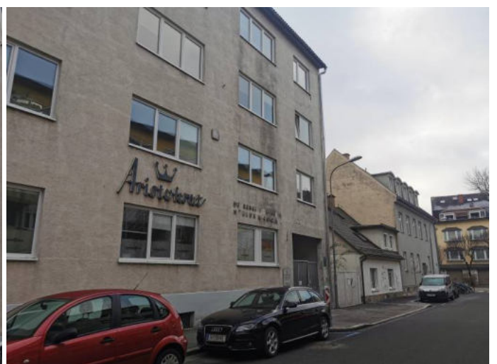
Foto 21: Blick in südwestliche Richtung auf die Bebauung der Liegenschaft Netzgasse 6
