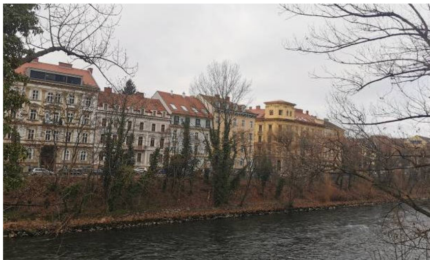
Foto 33: Blick vom linken Murufer, auf den Lendkai des rechten Murufers mit repräsentativen Bauten der Blockrandstruktur
