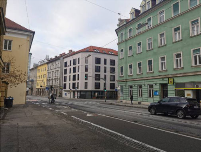
Foto 28: Blick in westliche Richtung vom Keplergymnasium (Keplerstraße 1) auf die gegenüberliegende Bebauung Keplerstraße 12 mit dazwischenliegender Neubaugasse und dem Eckgebäude Keplerstraße 14
