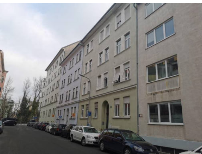
Foto 20: Blick in östliche Richtung auf die straßenraumbildende Blockrandbebauung entlang der südlichen Netzgasse auf Höhe Netzgasse 6
