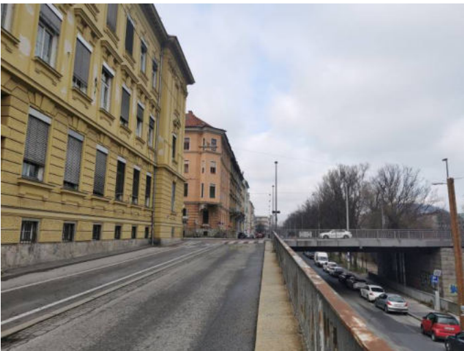
Foto 30: Blick in nordwestliche Richtung entlang des Lendkai, rechts ist die Keplerbrücke zu sehen, links das Gebäude des Keplergymnasiums
