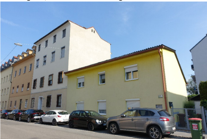
Foto 6: Blick in nordwestliche Richtung auf die Liegenschaften Lerchengasse 4 und 6 (viergeschossiges Gebäude links)
