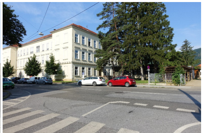
Foto 19: Blick in südwestliche Richtung auf das Schulgebäude der Neuen Mittelschule an der Algersdorfer Straße 11
