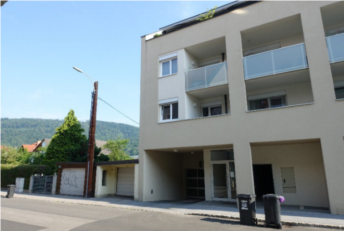
Foto 8: Blick in nordwestliche Richtung auf die dreigeschossige Bebauung mit Penthouse der Lerchengasse 16. Links davon befindet sich auf dem Bild die Garage der Liegenschaft Lerchengasse 18
