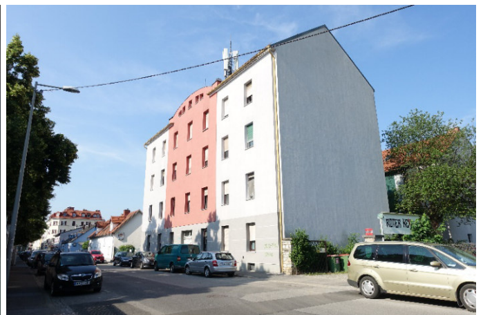
Foto 25: Blick in südwestliche Richtung auf das Wohngebäude Vinzenzgasse 47
