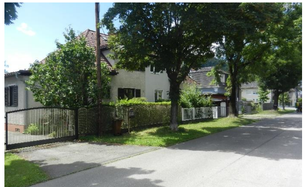
Abbildung 10: Blick auf die Bebauung Seidenhofstraße 85 und 87 in Richtung Südwesten
