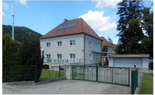
Abbildung 16: Blick auf die Bebauung Burenstraße 35b in Richtung Nordwesten.
