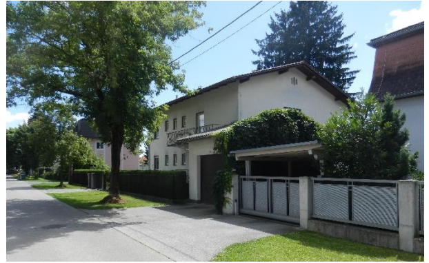
Abbildung 12: Blick auf die Bebauung Seidenhofstraße 81 in Richtung Südosten.
