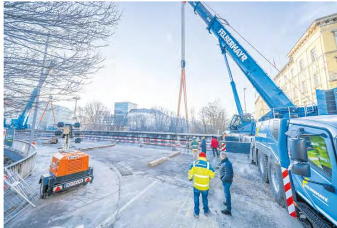
**Abgehoben.** Für die weitere Bearbeitung und Zerkleinerung wurde die südliche Hälfte der Stahlkonstruktion der Tegetthoffbrücke auf die noch bestehende nördliche Hälfte aufgesetzt.
