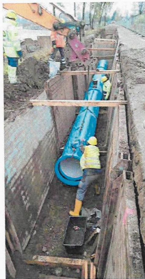
Verlegung TL 700, Abschnitt Kraftwerk
