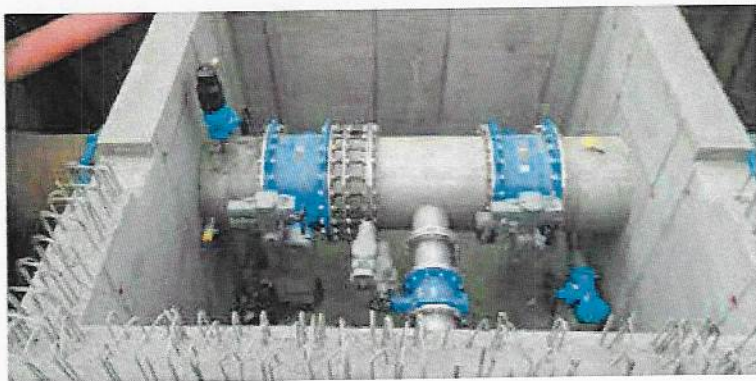
TL 700, Schacht Puchsteg neu
