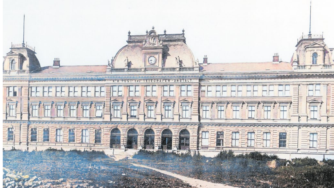
Die k. k. Post- und Telegraphen-Anstalt („Hauptpost“), Neutorgasse 46. 1887 wurde als späthistoristischer Monumental- und Repräsentationsbau auf dem Neutorplatz dieser schlossartige Gebäudekomplex errichtet.
