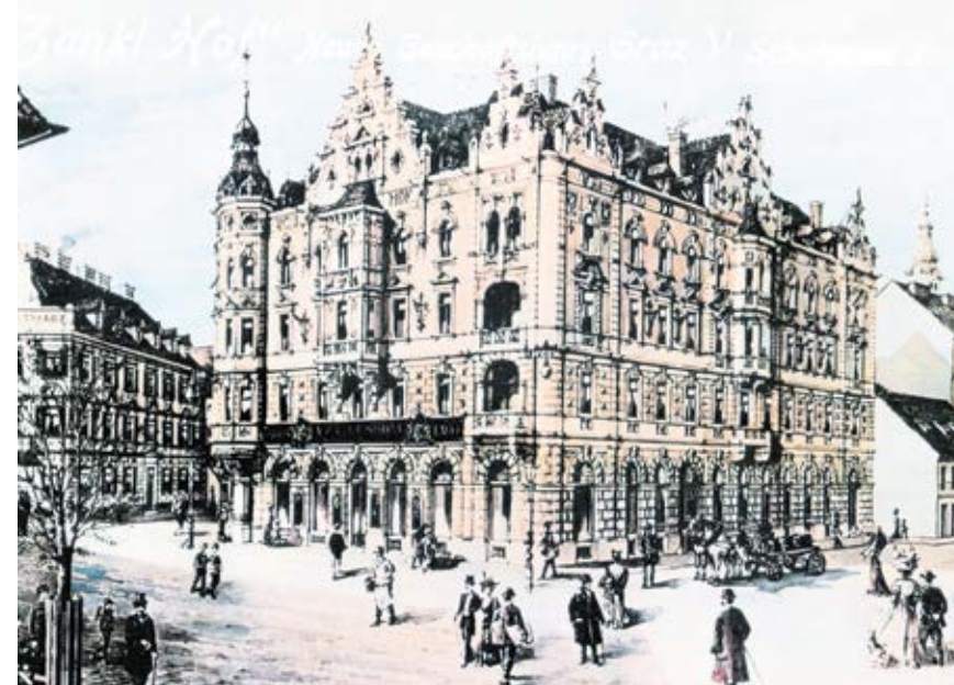
Der Zankl-Hof (1908, Planung Hans Pruckner), Maria-Stromberger-Gasse 2, einst Verwaltung und Geschäft der „Farben- und Lack-Werke A. Zankl Söhne“, nun Stadtbibliothek Graz.
