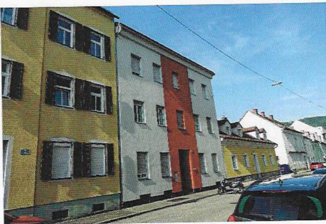
Foto 10: Blick in südöstliche Richtung, im Vordergrund ist die dreigeschossige Bebauung der Lerchengasse 3, rechts davon die Lerchengasse 5, rechts davon die eingeschossige Bebauung der Lerchengasse 7 zu sehen
