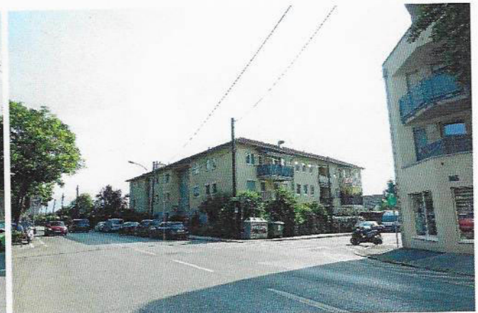
Foto 23: Blick in nordöstliche Richtung auf die Eckbebauung zum Kreuzungsbereich Lerchengasse / Algersdorfer Straße im gegenständlichen Bebauungsplangebiet
