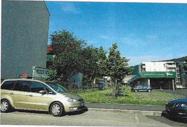
Foto 26: Blick in westliche Richtung auf die TG-Einfahrt des „Wohnquartiers St. Vinzenz“, links davon das Wohngebäude Vinzenzgasse 47 mit dem dahinterliegenden Wohngebäude Vinzenzgasse 47a
