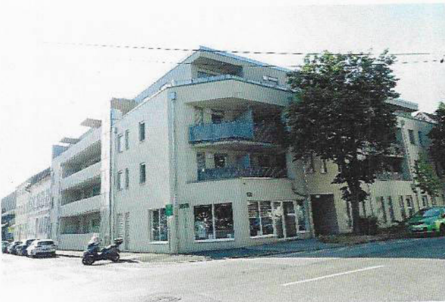
Foto 22: Blick in südöstliche Richtung auf die Eckbebauung zum Kreuzungsbereich Lerchengasse / Algersdorfer Straße südlich des gegenständlichen Bebauungsplangebiets
