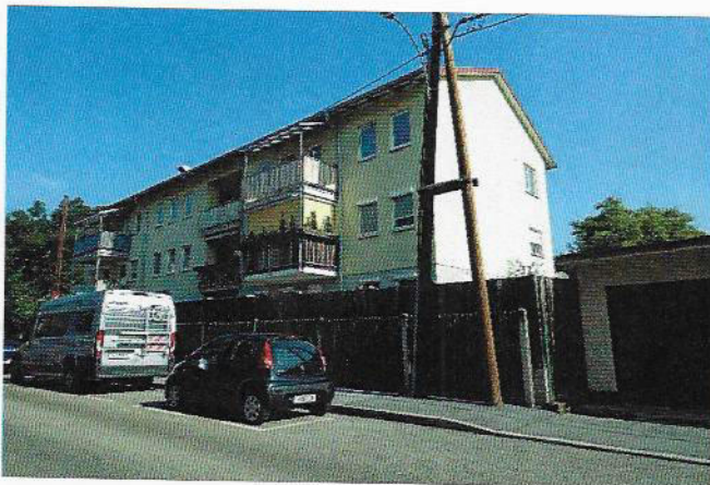
Foto 18: Blick in nordwestliche Richtung auf die dreigeschossige Bebauung Algersdorfer Straße 14
