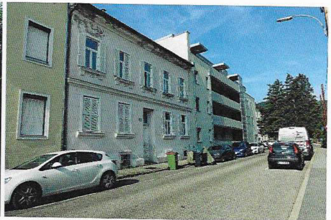
Foto 17: Blick in südwestliche Richtung, in Bildmitte die zweigeschossige Bebauung der Lerchengasse 31, dahinter die Bebauung der Liegenschaft Algersdorfer Straße 12
