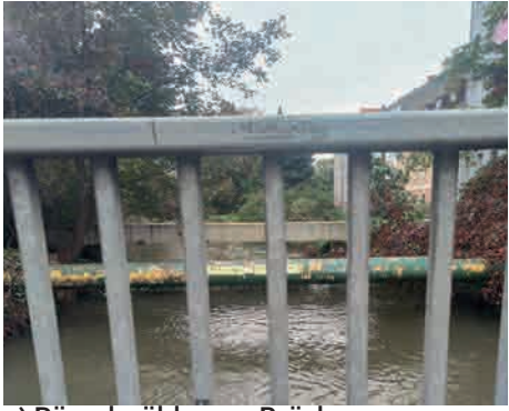
3) Rösselmühlgasse Brücke Keine Zugänglichkeit zum Wasser Sichtbare technische Verrohrung
