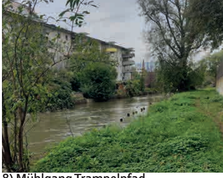
8) Mühlgang Trampelpfad Grünes Ufer mit Einzelgehölzen Fehlende Uferbefestigung
