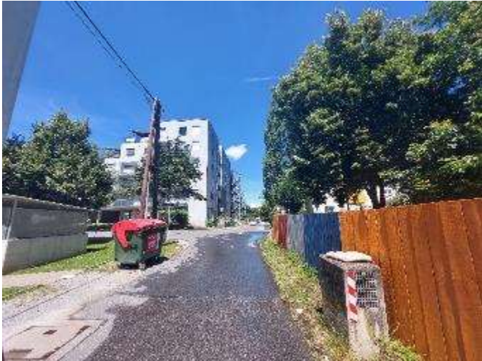
Foto 24: Blick in nördliche Richtung auf den Kreuzungsbereich Fröhlichgasse / Mühlgangweg / Am Langedelwehr.
