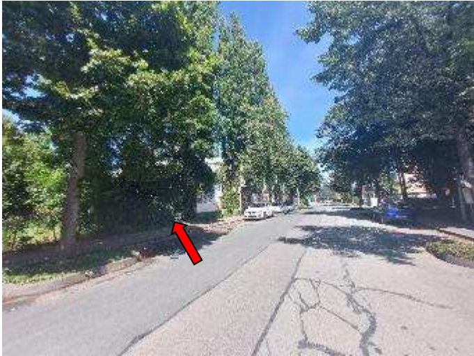
Foto 6: Blick in nördliche Richtung entlang der Neuholdaugasse Höhe Hausnr. 102. Der rote Pfeil markiert das Bebauungsplangebiet.
