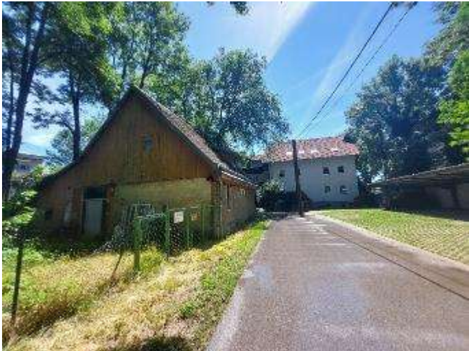
Foto 20: Blick in südliche Richtung entlang des Mühlgangwegs. 1-geschossiges Gebäude mit Satteldach am Grundstück der Caritas Graz Seckau ersichtlich.
