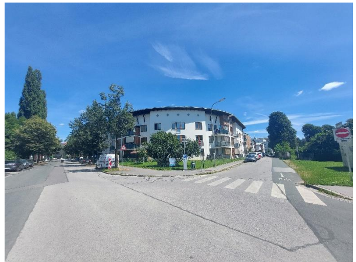
Foto 9: Blick in nordöstliche Richtung im Kreuzungsbereich Neuholdaugasse / Trattenweg auf ein 3- bis 4-geschossiges Wohngebäude am Grundstück „Trattenweg 16 - 20“.
