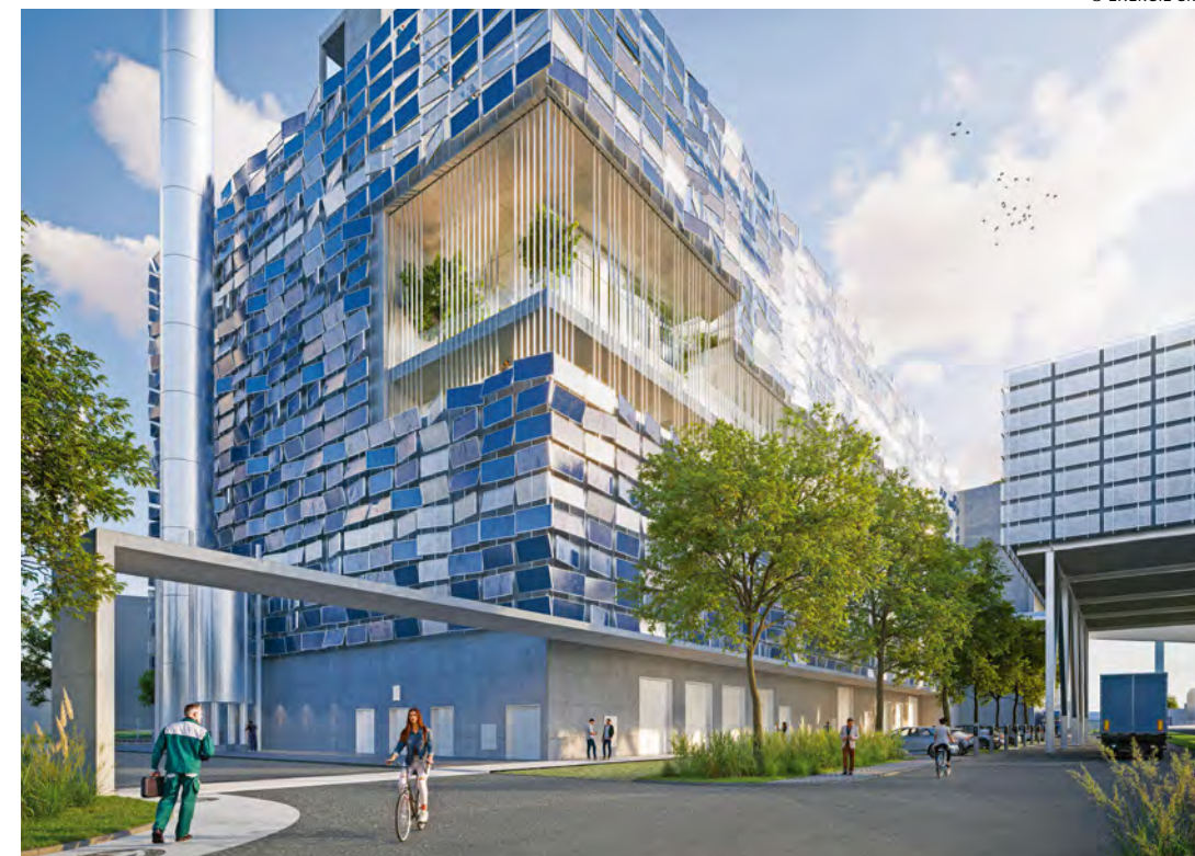
Form und Funktion. Auch das Erscheinungsbild des neuen Energiewerks Graz zeigt die ökologischen Bestrebungen des Projekts: Photovoltaik-Paneele als zentrales Element der Fassadengestaltung.
