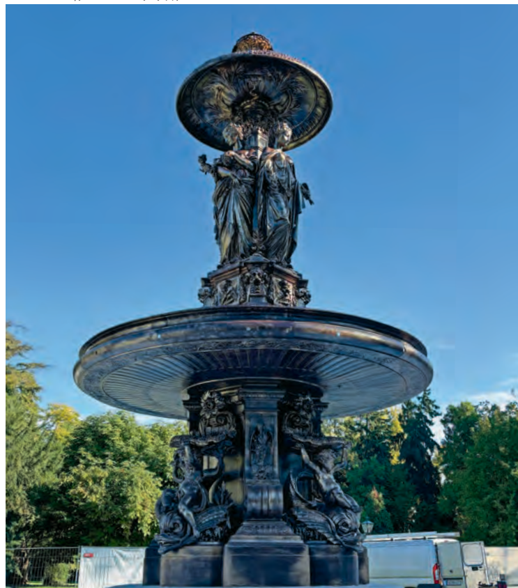
Rückkehr. Nach einer acht Monate dauernden Sanierung ist der renovierte Stadtparkbrunnen jetzt wieder zurück an seinem angestammten Platz.
