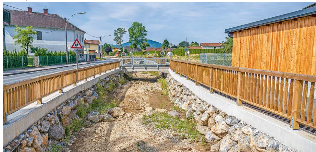
Weit fortgeschritten. Der vierte Bauabschnitt am Schöcklbach bietet bereits vor seiner Fertigstellung weitreichenden Schutz.
