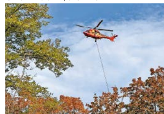
Heli-Einsatz. Sanierung der Brücke über die Schloßbergbahn.
