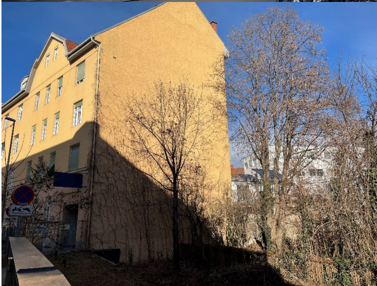
Foto 12: Gartenfläche Gst.Nr. 150: Blick Richtung Norden: Pfeil zeigt auf das Ge- bäude: Keesgasse 7 - 9
