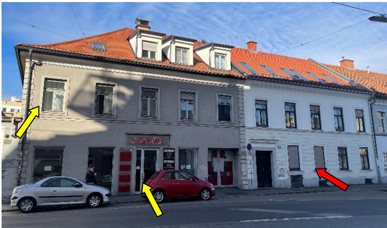
Grazbachgasse 60 und Grazbachgasse 58: 2-geschossiges Gebäude mit Satteldach, Gebäudehöhe: 7,9 m, Gesamthöhe 13,6 m
