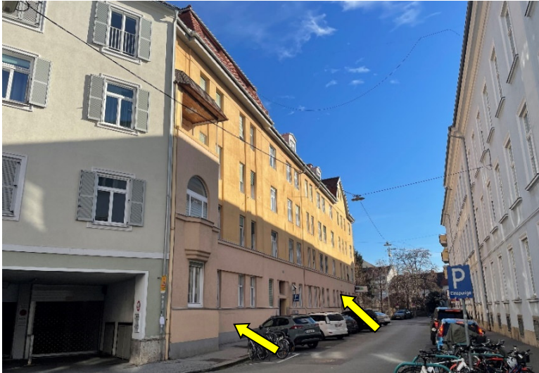
Foto 11: Keesgasse: Blick Richtung Südosten: Pfeile zeigen auf das Gebäude: Keesgasse 7 - 9
