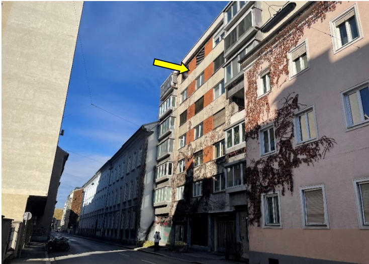
Foto 14: Wielandgasse: Blick Richtung Norden: Pfeil zeigt auf das Ge- bäude: Wielandgasse 11
