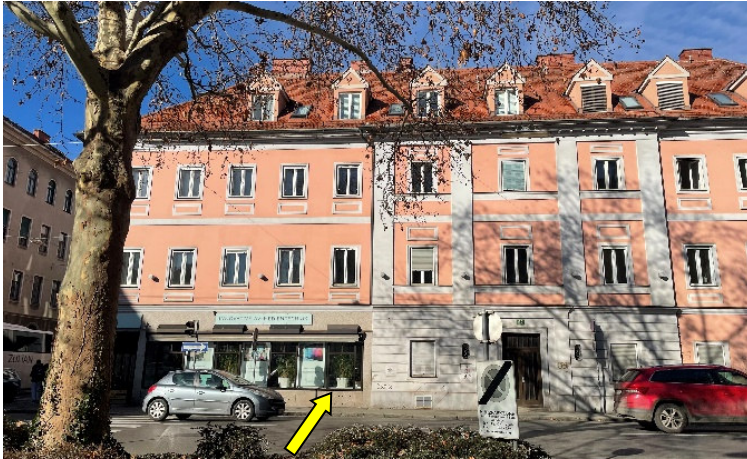
Grazbachgasse 62 / Wielandgasse 15: 3-geschossiges Eckgebäude mit Satteldach, Gebäudehöhe 12,1 m, Gesamthöhe: 18,2 m
