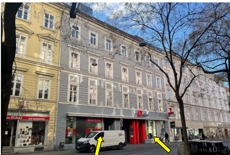
Foto 4: Radetzkystraße: Blick Richtung Südwesten: Pfeile zeigen auf das Gebäude: Radetzkystraße 9
