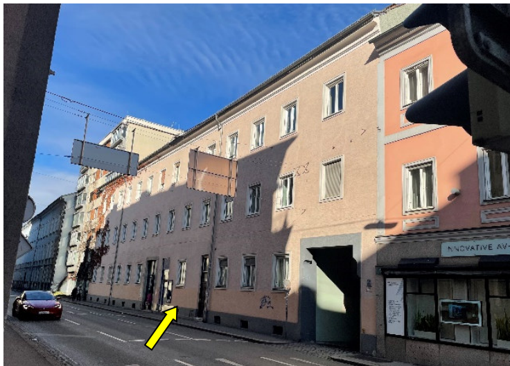
Foto 15: Wielandgasse: Blick Richtung Norden: Pfeil zeigt auf das Ge- bäude: Wielandgasse 13
