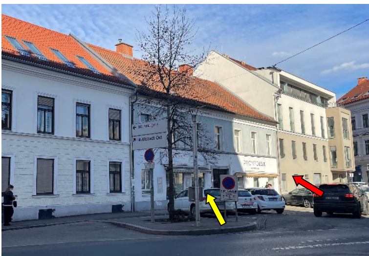
Grazbachgasse 56: 2-geschossiges Gebäude mit Satteldach Gebäudehöhe 8,0 m, Gesamthöhe: 12,6 m
