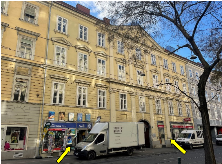
Foto 3: Radetzkystraße: Blick Richtung Südwesten: Pfeile zeigen auf das Gebäude: Radetzkystraße 7
