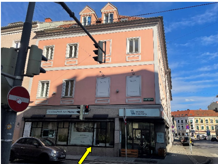
Foto 16: Wielandgasse: Blick Richtung Osten: Pfeil zeigt auf das Gebäude: Wielandgasse 15 / Grazbachgasse 62
