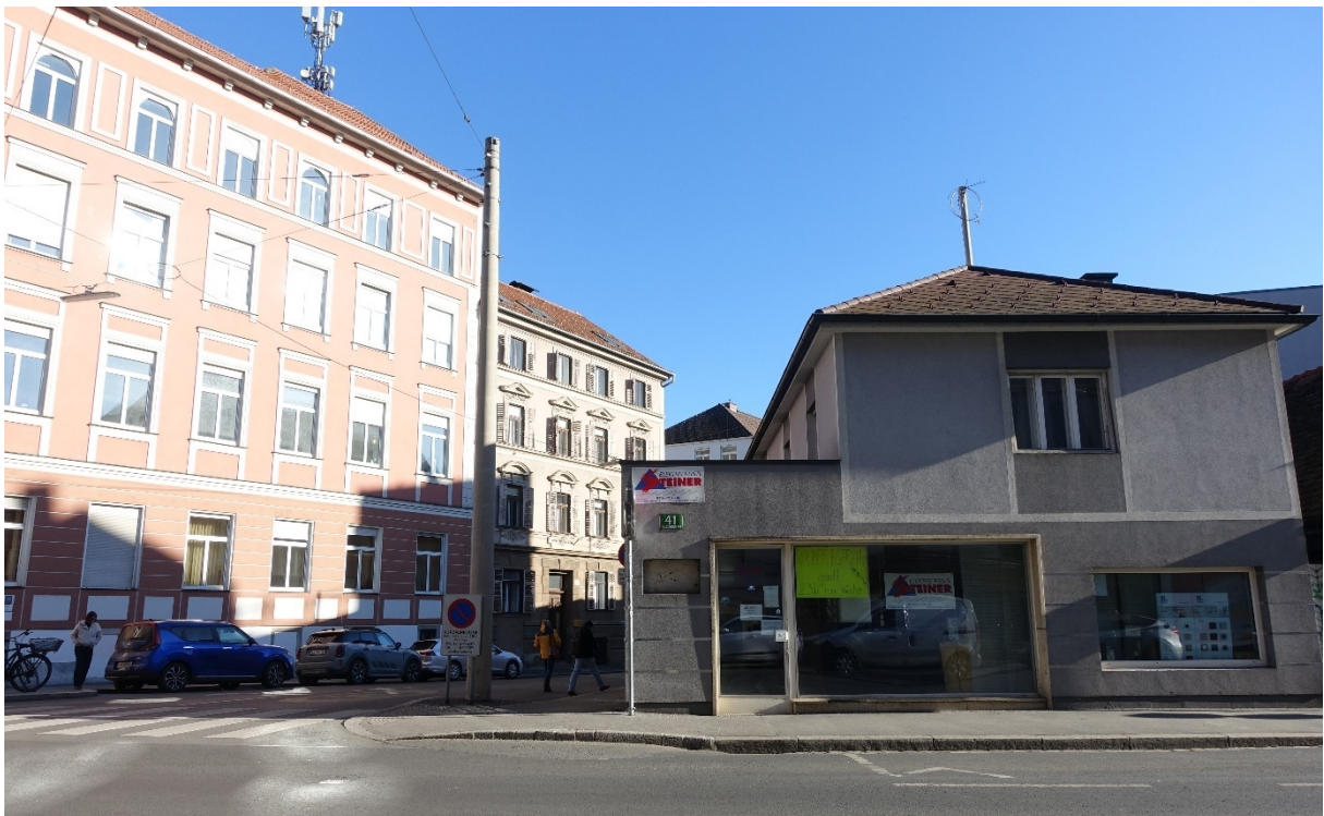
Foto 15: Blick in südöstliche Richtung auf die Kreuzung Maygasse / Grazbachgasse, rechts im Bild ist die 1- bzw. 2-geschossige Bebauung der Liegenschaft Grazbachgasse 41 zu sehen
