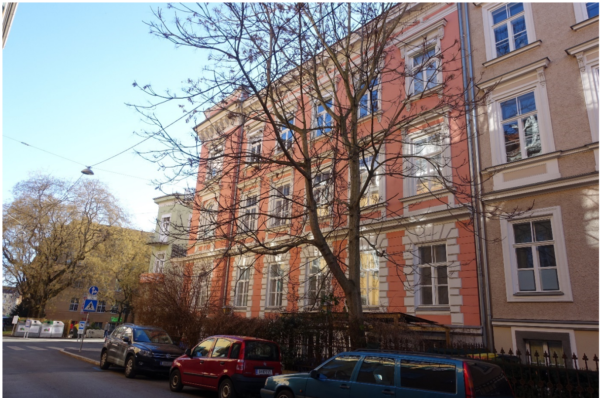
Foto 4: Blick in südwestliche Richtung, rechts im Vordergrund ist die Eckbebauung der Liegenschaft Maygasse 12 / Schießstattgasse 30 zu sehen. Im Hintergrund befindet sich der Ortweinplatz mit dem dreigeschossigen Gebäude der Modeschule Graz
