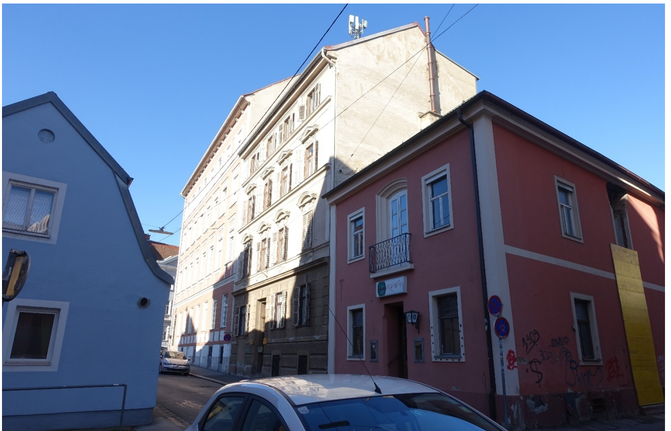
Foto 8: Blick in nördliche Richtung auf die Gebäude der Liegenschaften Maygasse 5 (linkst im Vordergrund), Maygasse 3 (4-geschossiges Gebäude) und Maygasse 1 (Eckbebauung Maygasse / Grazbachgasse)
