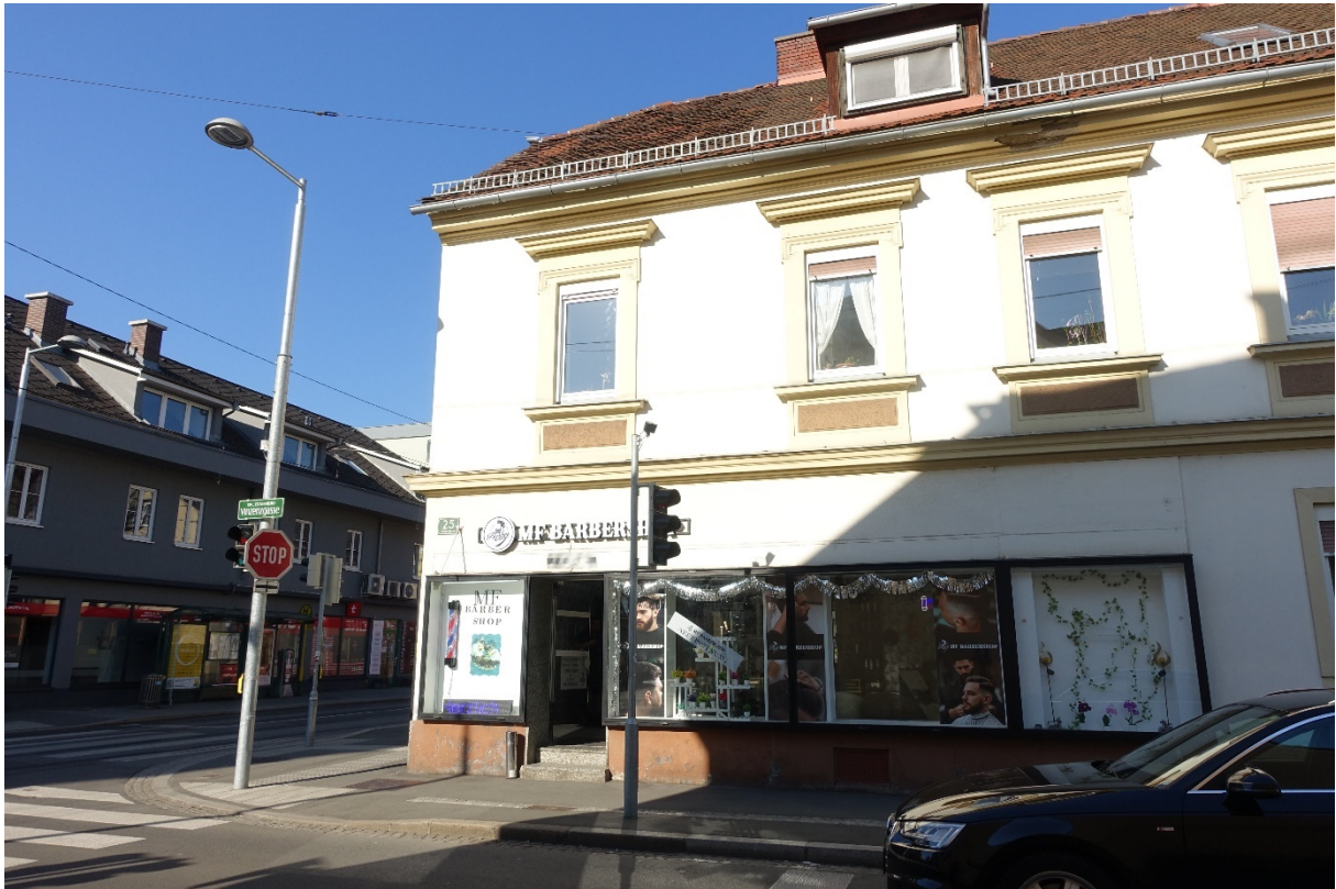
Foto 1: Blick in südöstliche Richtung. Im Vordergrund ist das Gebäude der Liegenschaft Vinzenzgasse 25 bzw. Georgigasse 32 zu sehen, im Hintergrund die Liegenschaft Georgigasse 25
