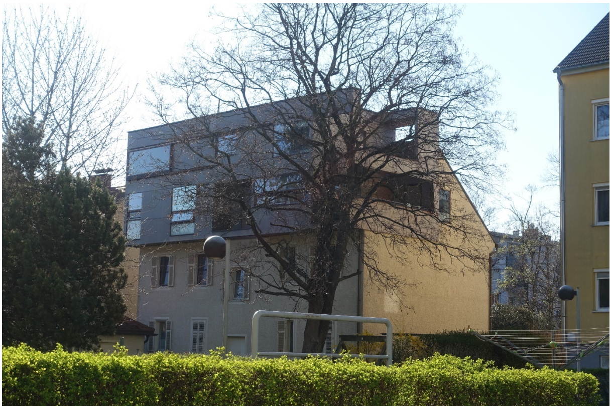
Foto 25: Blick in südöstliche Richtung auf die Innenhofseite des Gebäudes der Georgigasse 46a
