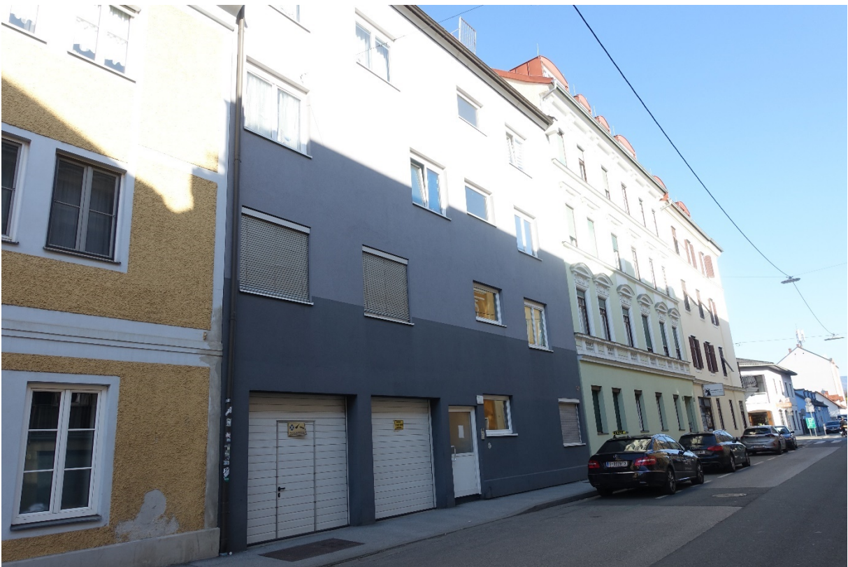
Foto 4: Blick in nordwestliche Richtung. Ganz links im Vordergrund ist das Gebäude der Liegenschaft Vinzenzgasse 31 /Rochelgasse 30, weiter (von links nach rechts) sind die Liegenschaften Vinzenzgasse 31, 33, 35 und 37 zu sehen
