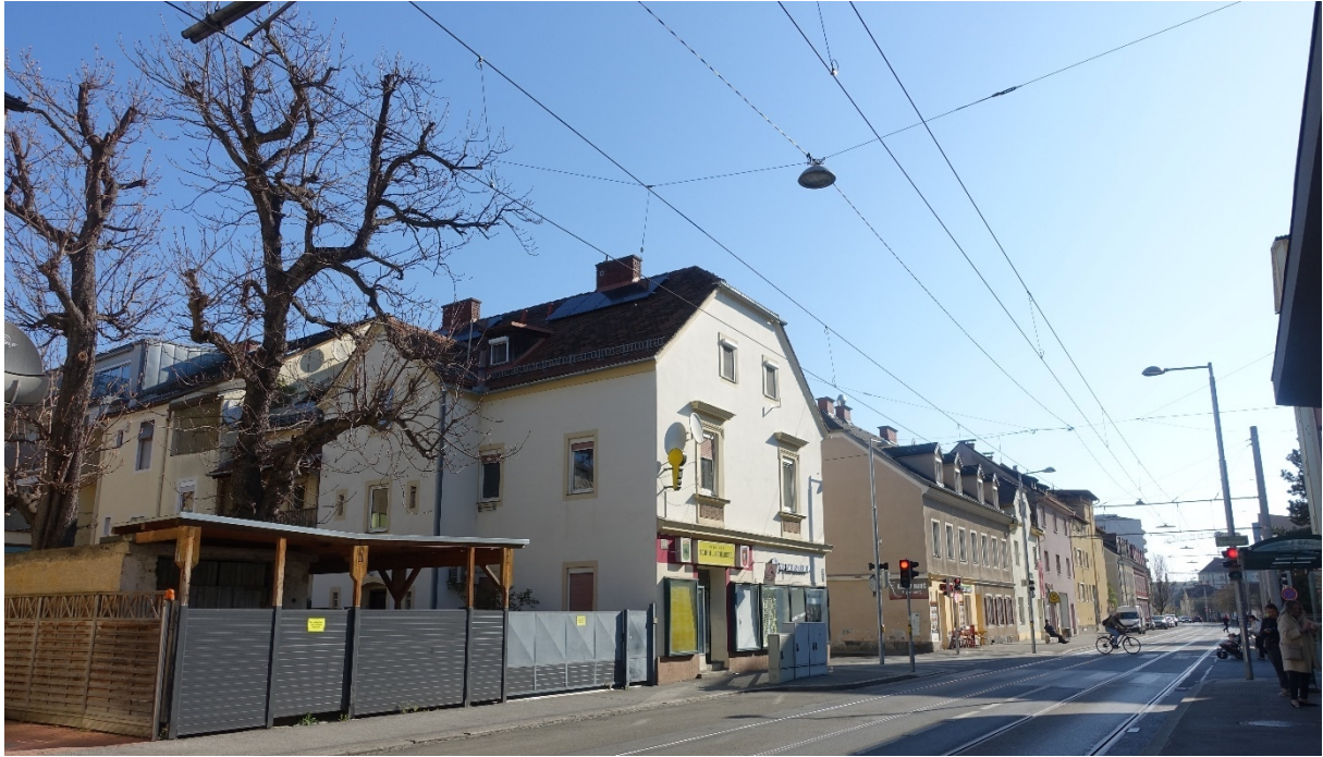
Foto 38: Blick in nordöstliche Richtung Liegenschaft Vinzenzgasse 25 bzw. Georgigasse 32. Im Hintergrund der weitere Verlauf der Georgigasse nach Osten mit zwei- bis dreigeschoßigen straßenraumbildenden Gebäuden
