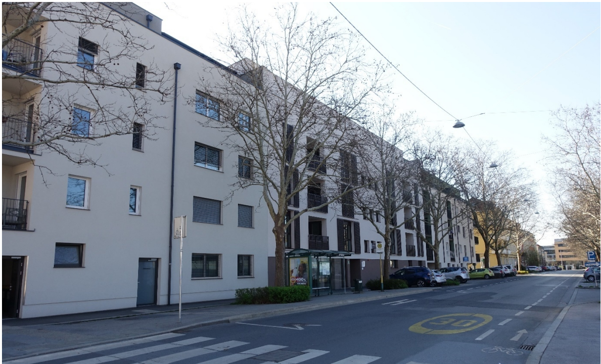
Foto 44: Blick in südöstliche Richtung auf die Bebauung der Janzgasse 26 und 22
