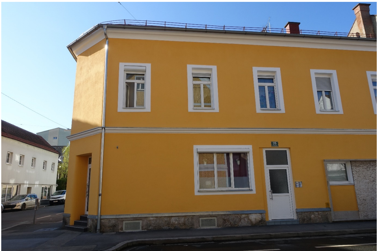
Foto 33: Blick in südliche Richtung auf das Gebäude Rochelgasse 25
