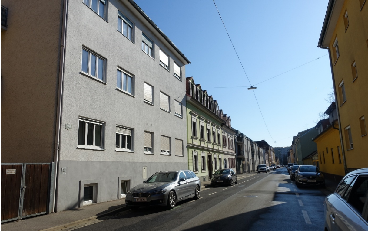
Foto 26: Blick in östliche Richtung. Links im Vordergrund ist das Gebäude der Liegenschaft Rochelgasse 58 zu sehen, dahinter befinden sich die Gebäude der Liegenschaften Rochelgasse 46 und 44
