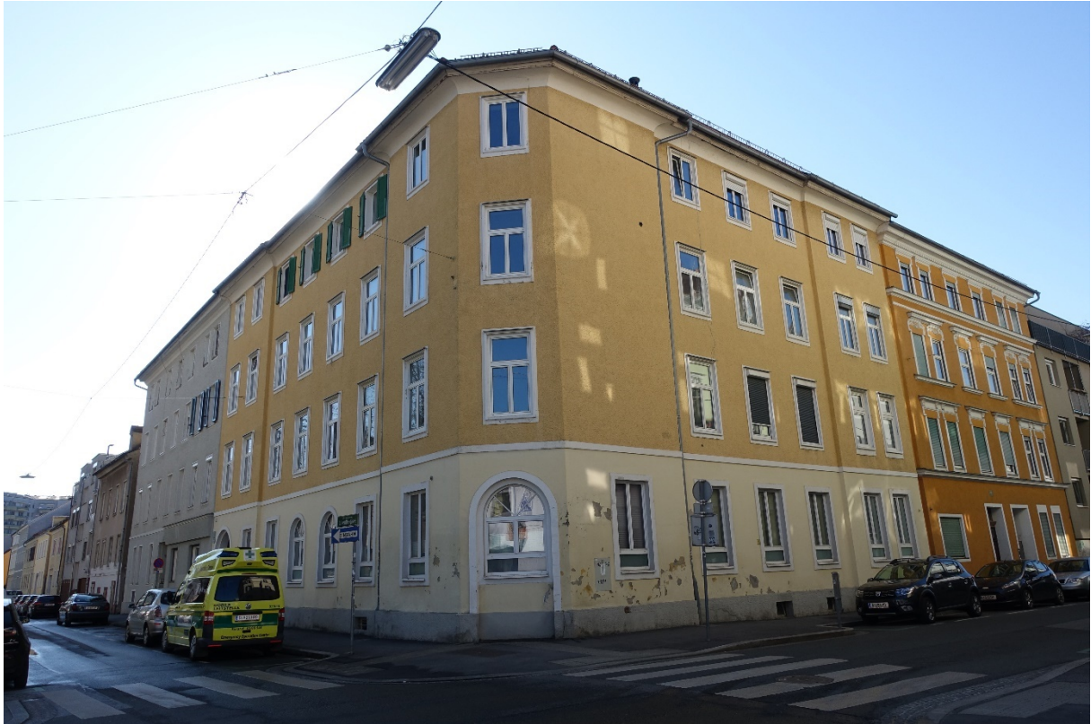
Foto 7: Blick von der Kreuzung Rochelgasse/Vinzenzgasse auf das viergeschoßige Eckgebäude der Rochelgasse 23 östlich des Bebauungsplangebietes
