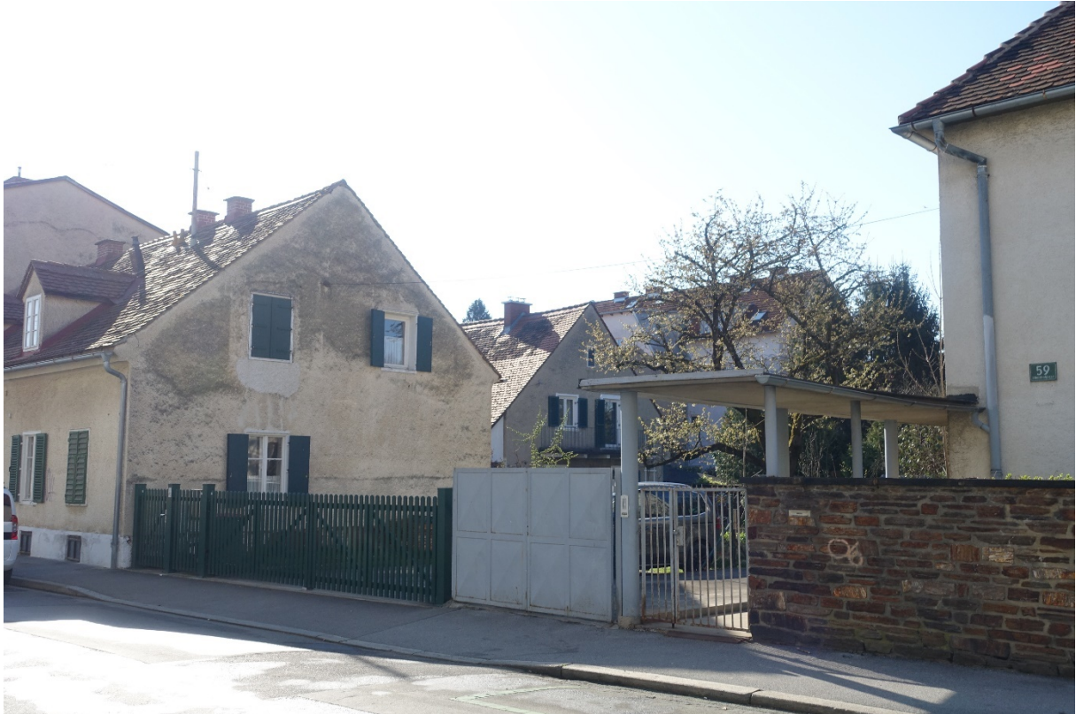
Foto 16: Blick in südöstliche Richtung. Rechts im Vordergrund ist das Gebäude der Liegenschaft Lilienthalgasse 59, östlich davon die Liegenschaft Lilienthalgasse 57 zu sehen
