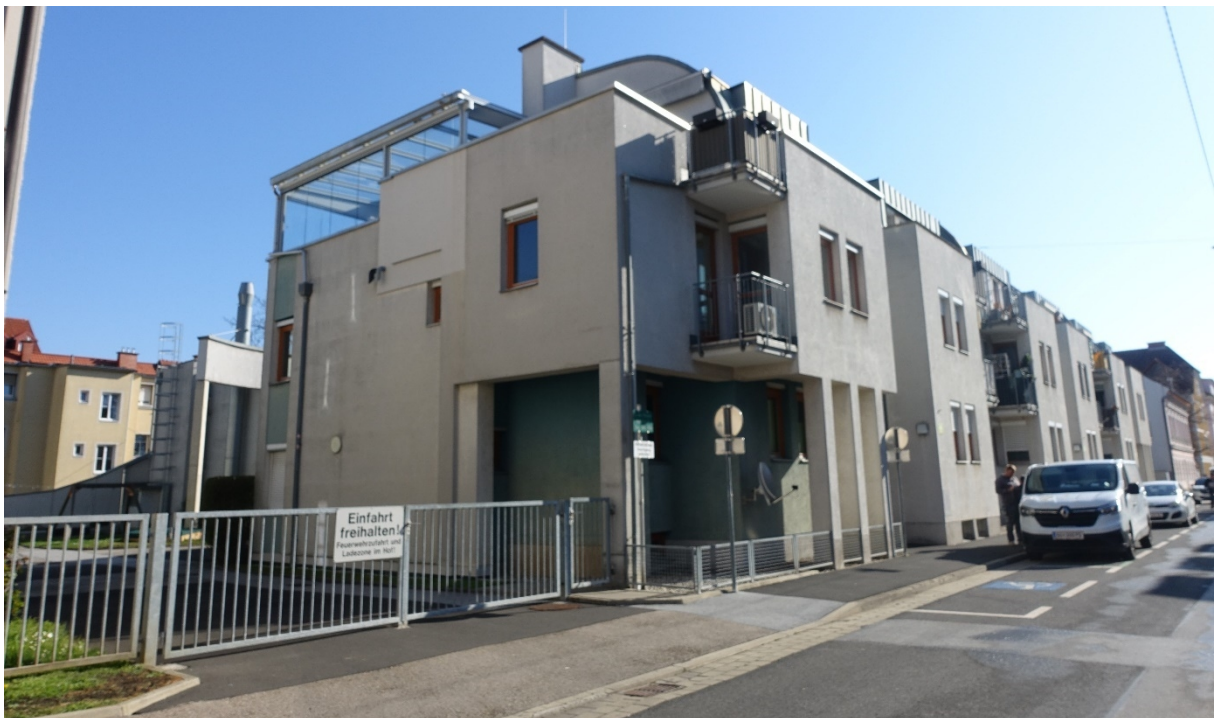
Foto 29: Blick in nordöstliche Richtung auf die Liegenschaften der zweigeschoßigen Wohnanlage Rochelgasse 38 und 40
