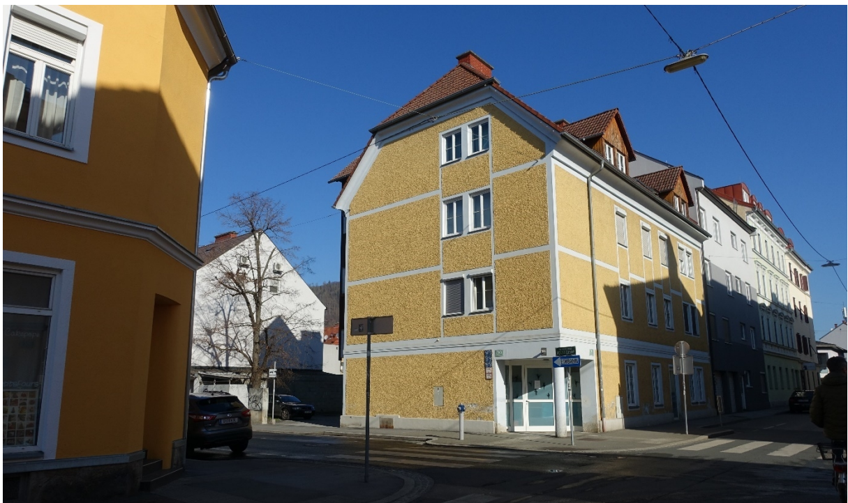
Foto 2: Blick in nordwestliche Richtung. In Bildmitte ist das Gebäude der Liegenschaft Vinzenzgasse 31 /Rochelgasse 30 zu sehen
