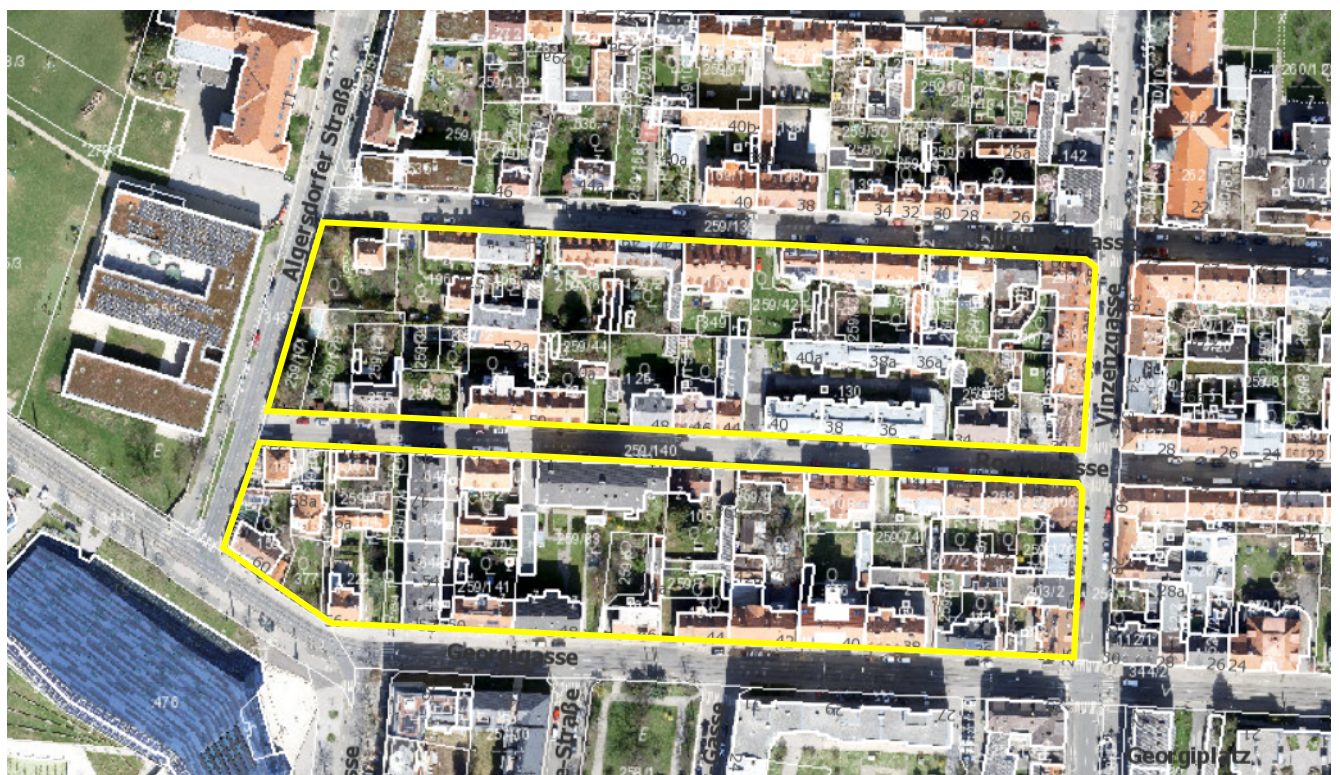
Luftbild 1: Orthofoto (2024) mit Kataster, Aufnahme©Stadt Graz. Die beiden Rahmen kennzeichnen das Bebauungsplangebiet
