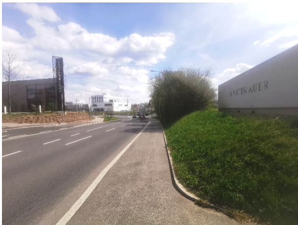
Abbildung 13: Blick in Richtung Südosten auf den Beginn der Maggstraße, ausgehend vom St.-Peter-Gürtel. Die Straße fällt bis zum Kreuzungsbereich leicht ab. Das Planungsgebiet liegt erhöhte (rechts im Bild).
