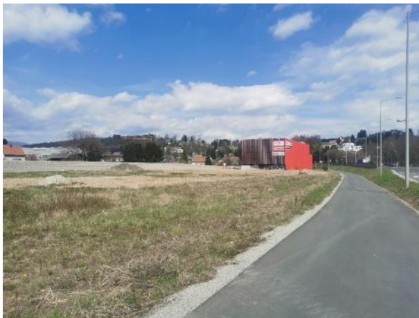
Abbildung 5: Blick in Richtung Osten. Neu errichtete Erschließungsstraße zur inneren Erschließung innerhalb des 08.24.1 Bebauungsplangebiets „St.- Peter-Gürtel-Maggstraße“
