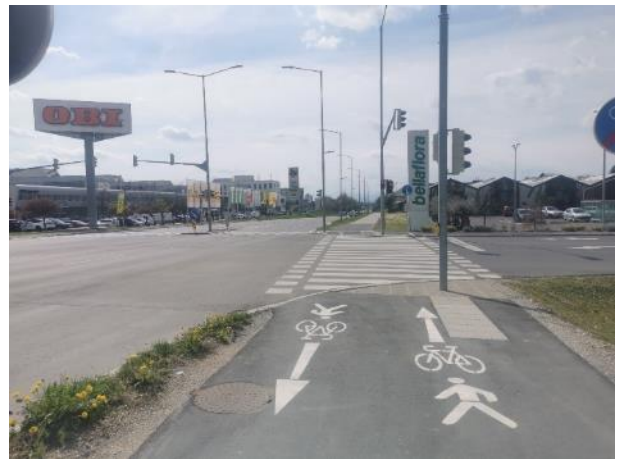
Abbildung 6: Blick in Richtung Südwesten. St.-Peter-Gürtel mit begleitendem Geh- u. Radweg an der Nordseite.
