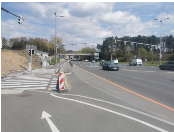
Abbildung 1: Blick in Richtung Nordosten, Liebenauer Gürtel im Bereich des Autobahnzubringers Raaba.
