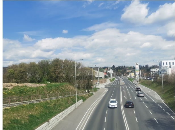
Abbildung 16: Blick in Richtung Nordosten auf den St.-Peter-Gürtel. Links im Bild zeigt sich das Planungsgebiet mit dem neu errichteten Geh- u. Radweg, der eine Verbindung zw. Neufeldweg und St.-Peter-Gürtel herstellt.
