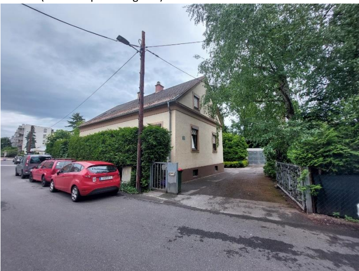
Foto 15: Blick in nordöstliche Richtung auf das Grundstück „Lindengasse 16“.
