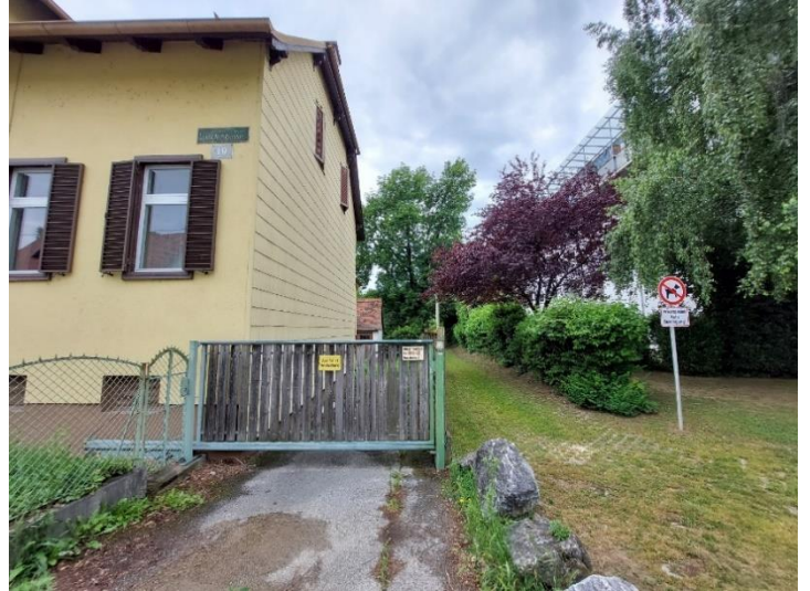
Foto 6: Blick in südwestliche Richtung entlang der Lindengasse Höhe Hausnr. 19 (Grundstück der Antragsteller:in).
