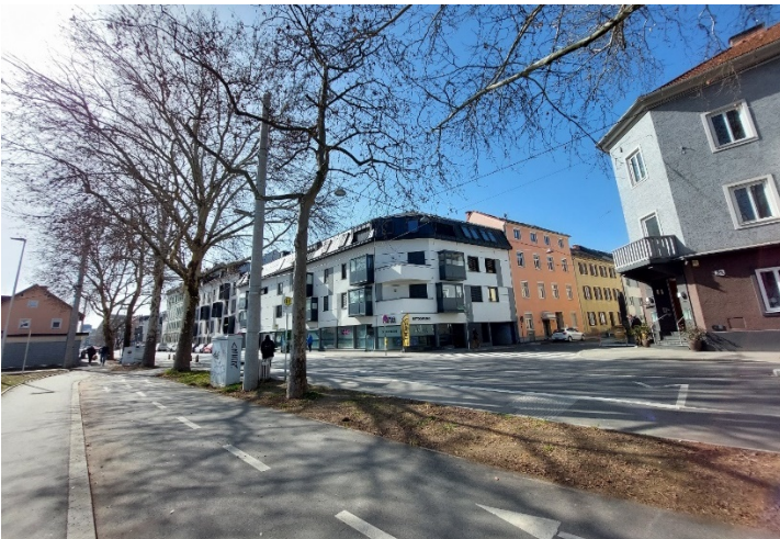
Foto 17: Blick in südwestliche Richtung im Kreuzungsbereich Alte Poststraße / Bodenfelsgasse, links am Foto befindet sich das gegenständliche Bebauungsplangebiet. 3- bis 4-geschossige Blockrandbebauung entlang der westlichen Straßenseite der Alten Poststraße.
