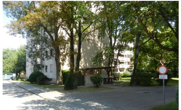
Abbildung 16: Blick auf die Bebauung Petersgasse 25 und 25a in Richtung Osten
