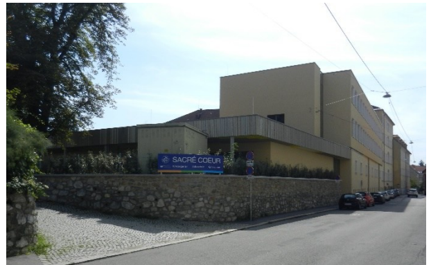
Abbildung 30: Blick entlang der Schörgelgasse Höhe Nr. 59 in Richtung Südwesten
