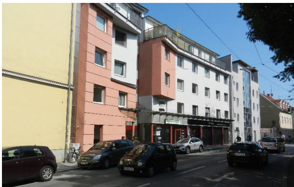
Abbildung 27: Blick auf die Bebauung Petersgasse 15 und 19 in Richtung Südosten
