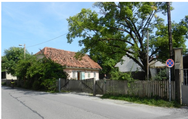
Abbildung 21: Blick auf die Bebauung Schörgelgasse 64 in Richtung Südosten
