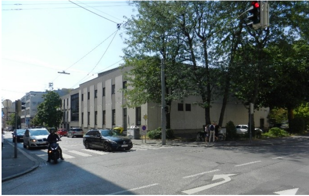
Abbildung 13: Kreuzung Petersgasse/Steirergasse in Richtung Südwesten
