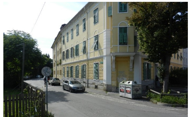
Abbildung 2: Kreuzung Schörgelgasse/Naglergasse Blick Richtung Südwesten
