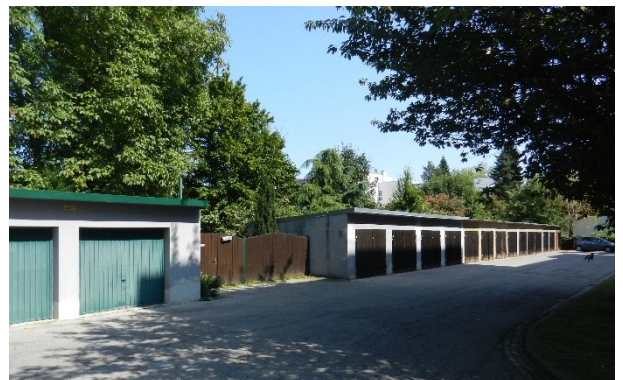
Abbildung 18: Blick auf die Garagenanlage am Ende der Stichstraße Blick Richtung Südosten
