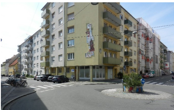
Abbildung 7: Kreuzung Schörgelgasse/Rechbauerstraße in Richtung Nordwesten
