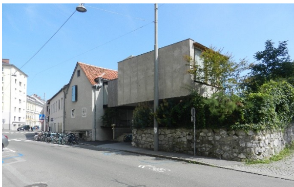
Abbildung 31: Blick auf die Bebauung Schörgelgasse 48 in Richtung Südosten
