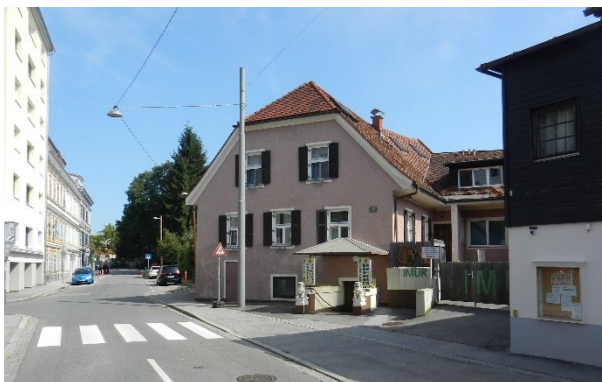
Abbildung 33: Blick vom Kreuzungsbereich Schörgelgasse/ Krenngasse in Richtung Südosten
