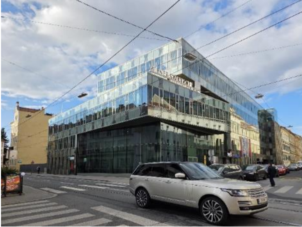
Foto 1. Blick in Richtung Nordwesten auf die Liegenschaft Münzgrabenstraße 31.
