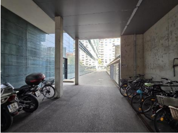
Foto 19. Blick in Richtung Osten. Durchgang von der Brockmannngasse zum Vorplatz der „Neuen Chemie“ der TU-Graz.
