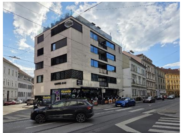
Foto 24. Blick in westliche Richtung auf das Haus Brockmannngasse 36 im Kreuzungsbereich zwischen der Münzgrabenstraße und der Brockmannngasse.
