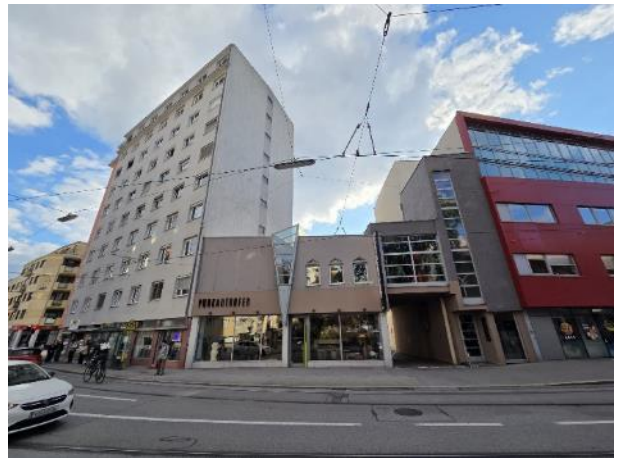
Foto 4. Blick in Richtung Süden auf die Liegenschaften Münzgrabenstraße 44 (10-geschossiges Gebäude links) sowie Münzgrabenstraße 42 (Bildmitte).
