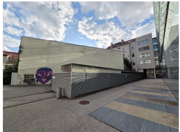
Foto 18. Blick in Richtung Westen. Bebauungsplangebiet (Innenhof). Brandwand der Hofbebauung, Liegenschaft Münzgrabenstraße 35a sowie Müll- u. Lagergebäude der TU-Graz (außerhalb des Bebauungsplangebiets).
