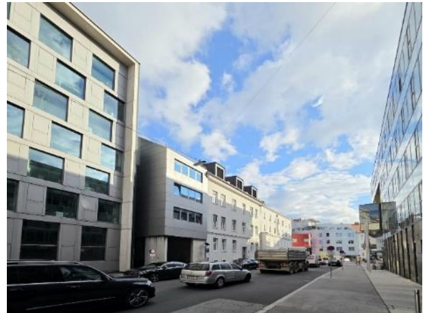
Foto 22. Blick in Richtung Süden. Die Gebäude links der Straße liegen alle innerhalb des Bebauungsplangebiets.
