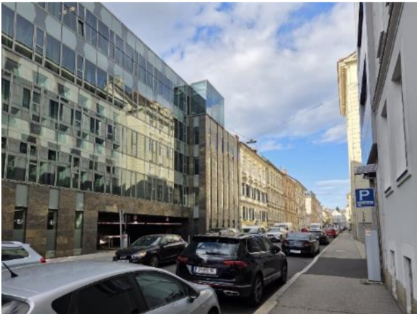
Foto 21. Blick in Richtung Norden. Nordseite der Brockmannngasse stadtauswärts. Fassade des Gebäudes Brockmannngasse 29 (innerhalb des Bebauungsplangebiets) rechts im Bild.
