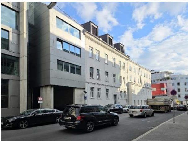
Foto 23. Blick in Richtung Süden. Blockrandbebauung innerhalb des Bebauungsplangebiets. Gebäudeaufstockungen wurden bereits vorgenommen.
