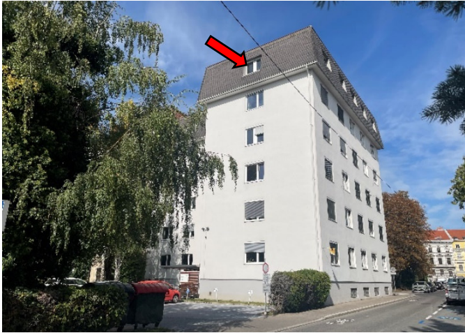
Foto 13: Schillerplatz 4 (roter Pfeil) Blick von der Herrandgasse Richtung Osten
