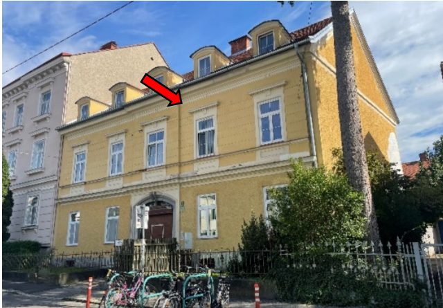
Foto 7: Schützenhofgasse 28 (roter Pfeil): Blick Richtung Osten
