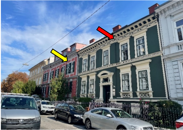
Foto 10: Schützenhofgasse 36 (roter Pfeil) und Schützenhofgasse 38 (gelber Pfeil):
