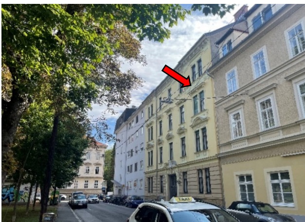
Foto 12: Schillerplatz 1, 2, 3, 3a und 4 Blick Richtung Süden
