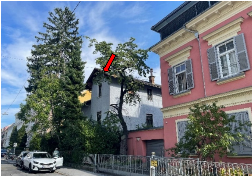
Foto 6: Schützenhofgasse 26 (roter Pfeil): Blick Richtung Osten
