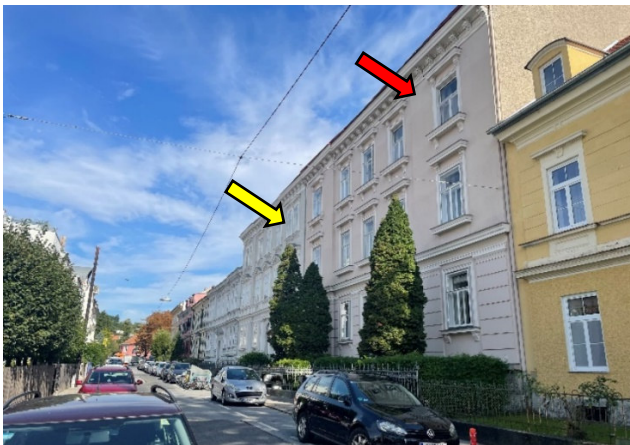
Foto 8: Schützenhofgasse 30 (roter Pfeil) und 32 (gelber Pfeil): Blick Richtung Osten
