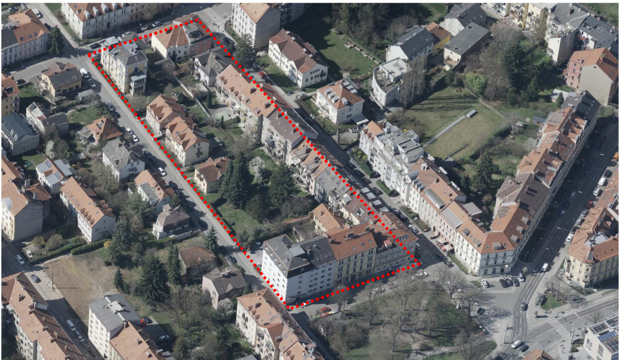
Luftbild 3 (2024): Schrägaufnahme aus den Geo-Daten-Graz (Measuree Graz 2024) ©Stadt Graz – Stadtvermessung Blick in Richtung Westen. Die rote Umrandung markiert das Bebauungsplangebiet.
