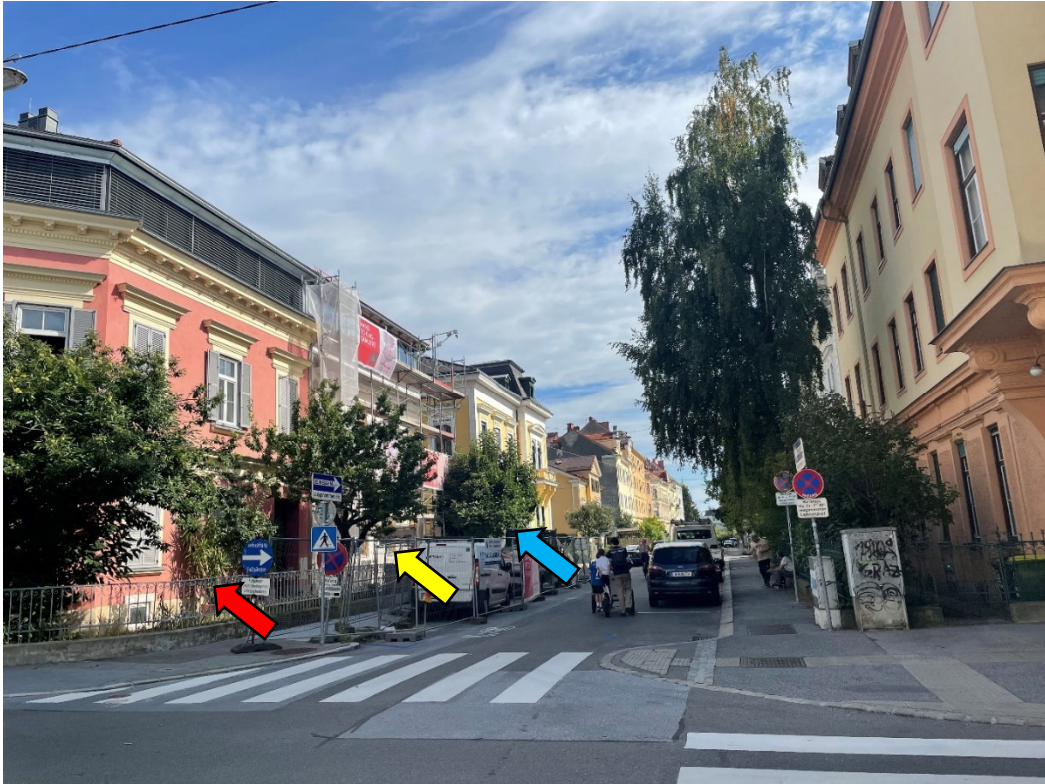
Foto 1: Naglergasse: Blick Richtung Süden: Roter Pfeil zeigt auf Schützenhofgasse 24 / Naglergasse 61, gelber Pfeil zeigt auf Naglergasse 63 und blauer Pfeil zeigt auf Naglergasse 65
