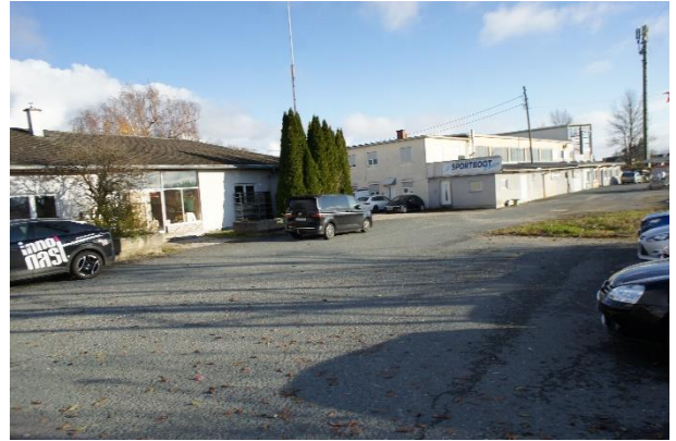
Blick auf gewerblich genutzte Liegenschaften (ehemalige Samitzgründe) südlich der Gradnerstraße auf Höhe Gradnerstraße 51. Blick Richtung Süden.
