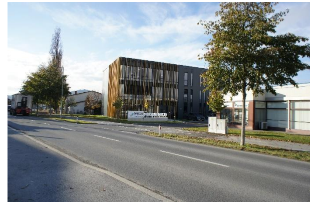
Blick in die Gradnerstraße auf Höhe Gradnerstraße 60. Blick Richtung Südwesten.
