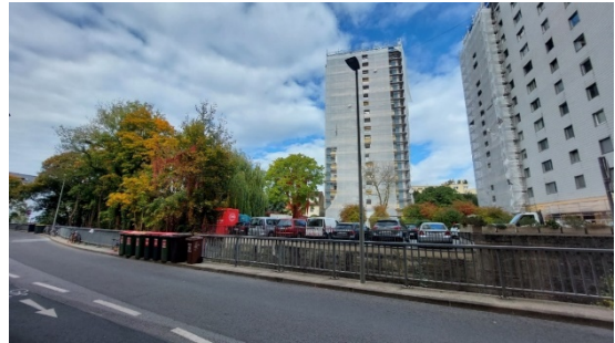
Foto 10: Blick in nordwestliche Richtung an der Sonnenstraße 16;
