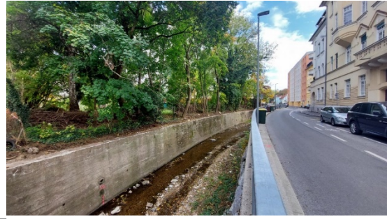
Foto 14: Blick in östliche Richtung an der Sonnenstraße 6;
