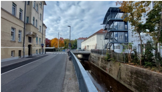
Foto 15: Blick in westliche Richtung an der Sonnenstraße 4;
