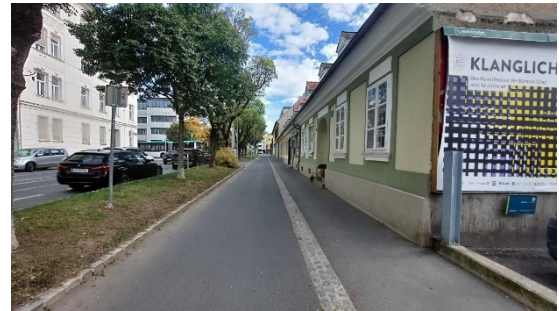
Foto 2: Blick in östliche Richtung an der Leonhardstraße 88;
