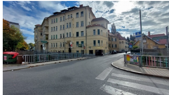
Foto 16: Blick in südöstliche Richtung im Kreuzungsbereich Reiterweg - Pappenheimgasse;
