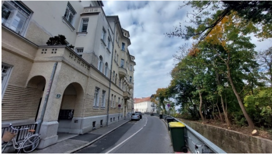
Foto 13: Blick in westliche Richtung an der Sonnenstraße 8;
