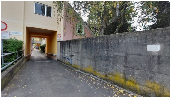
Foto 7: Blick in südliche Richtung an der Leonhardstraße 100;
