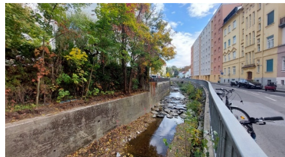
Foto 12: Blick in östliche Richtung an der Sonnenstraße 10;
