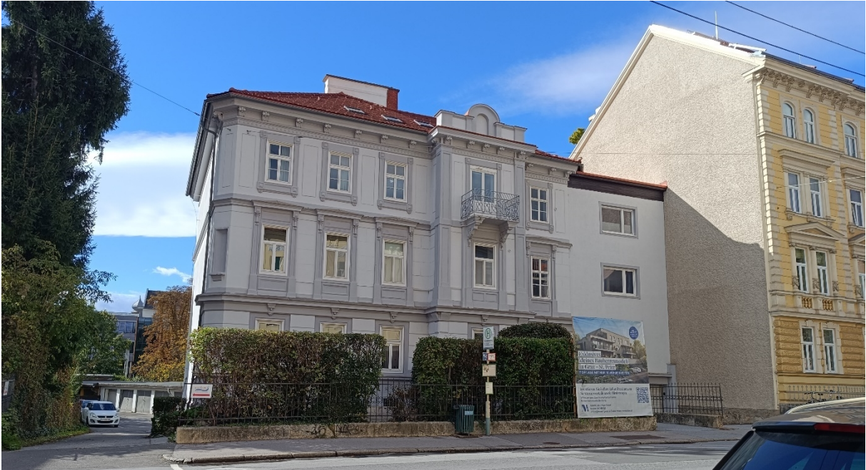
Foto 20: Blick in westliche Richtung auf die Liegenschaft Wielandgasse 28
