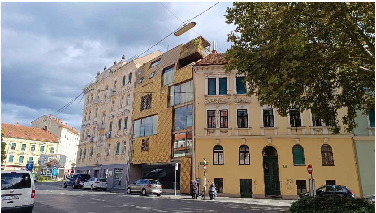
Foto 2: Blick in südöstliche Richtung auf die Bebauung entlang der Wielandgasse und der Grazbachgasse. Rechts im Bild das dreigeschossige Gebäude der Wielandgasse 17 mit Hochparterre, daneben der sechsgeschossige Bau jüngeren Datums der Grazbachgasse 65a mit einem flach geneigtem Dach und links davon kuppelnd das fünfgeschossige Gründerzeitgebäude Grazbachgasse 65
