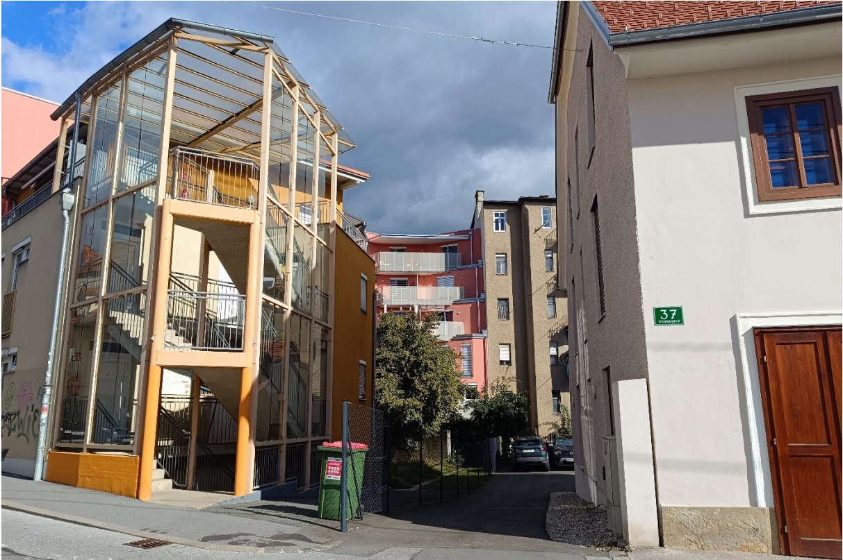
Foto 16: Blick in südöstliche Richtung auf die Schönaugasse 33, rechts davon die Schönaugasse 37
