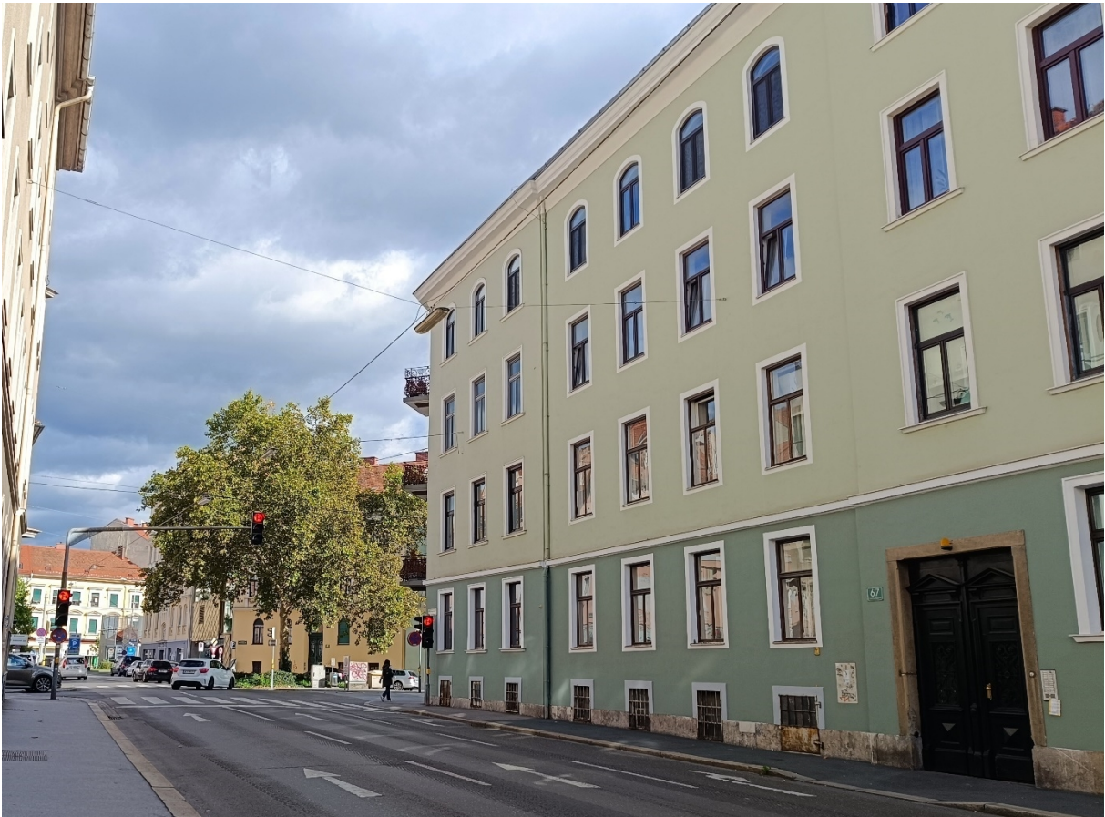
Foto 1: Blick in östliche Richtung entlang der Grazbachgasse auf Höhe Grazbachgasse 67 (rechts im Bild)
