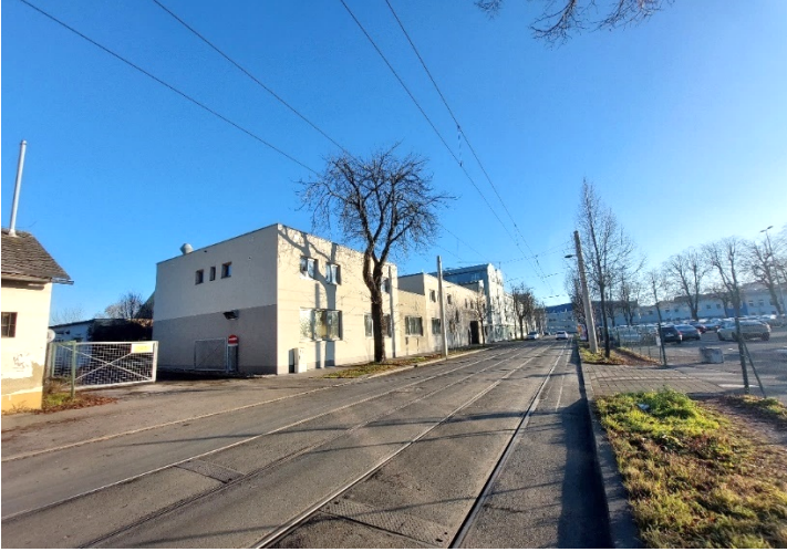
Foto 13: Blick in südliche Richtung entlang der Asperngasse – links am Foto das Bebauungsplangebiet.
