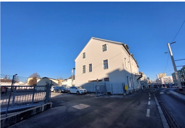
Foto 5: Blick in nordöstliche Richtung entlang der Eggenberger Straße Höhe Hausnr. 20 auf das Bebauungsplangebiet.
