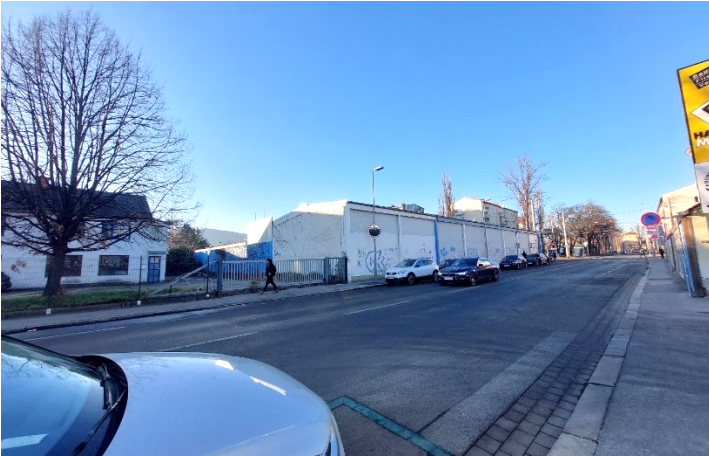
Foto 25: Blick in nordwestliche Richtung auf das Bebauungsplangebiet entlang der Waagner-Biro-Straße Höhe Hausnr. 11.
