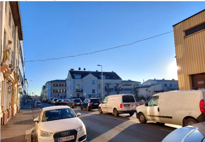
Foto 29: Blick in südliche Richtung entlang der Waagner-Biro-Straße Höhe Hausnr. 9 – rechts am Foto das Bebauungsplangebiet.
