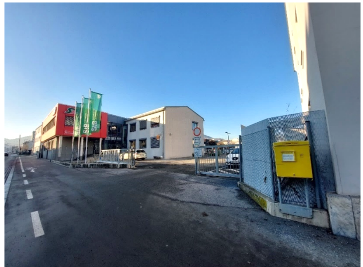
Foto 4: Blick in nordwestliche Richtung auf das Bebauungsplangebiet entlang der Eggenberger Straße Höhe Hausnr. 20.
