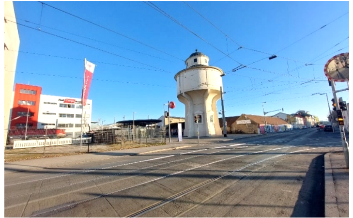
Foto 22: Blick in südöstliche Richtung entlang der Waagner-Biro-Straße Höhe Hausnr. 30 b auf den Wasserturm – nordöstlich gegenüber dem Bebauungsplangebiet.
