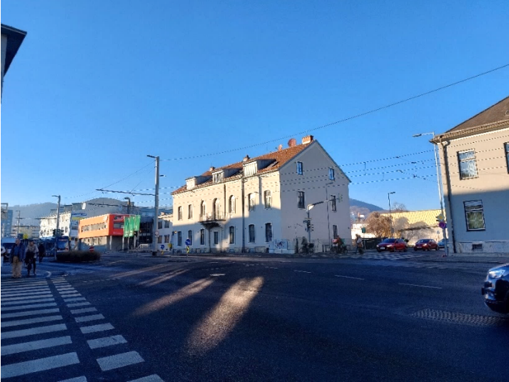
Foto 1: Blick in nordwestliche Richtung auf das Bebauungsplangebiet im Kreuzungsbereich Eggenberger Straße / Waagner-Biro-Straße.
