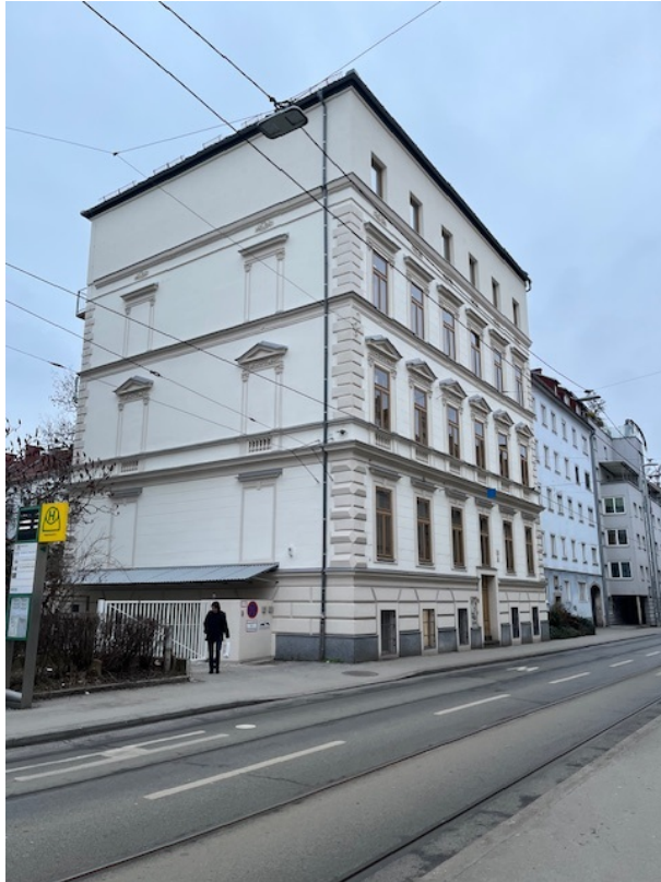
Foto 9: Leonhardstraße 78 Blick Richtung Westen
