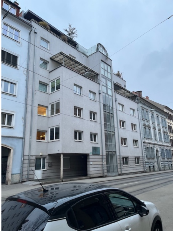
Foto 12: Leonhardstraße 74 Blick Richtung Westen
