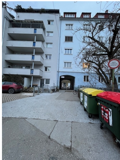
Foto 10 und 11: Leonhardstraße 76 Blick Richtung Westen bzw. Hofansicht Richtung Norden
