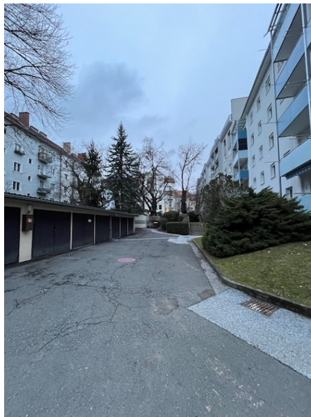
Foto 7 und 8 Pappenheimgasse 17 Blick Richtung Nordwesten bzw. Nordosten
