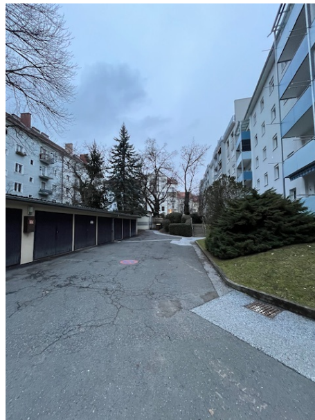
Foto 7 und 8 Pappenheimgasse 17 Blick Richtung Nordwesten bzw. Nordosten
