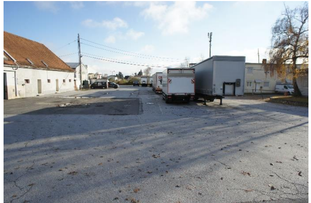
Blick auf gewerblich genutzte Liegenschaften (ehemalige Samitzgründe) südlich der Gradnerstraße auf Höhe Gradnerstraße 45. Blick Richtung Süden.
