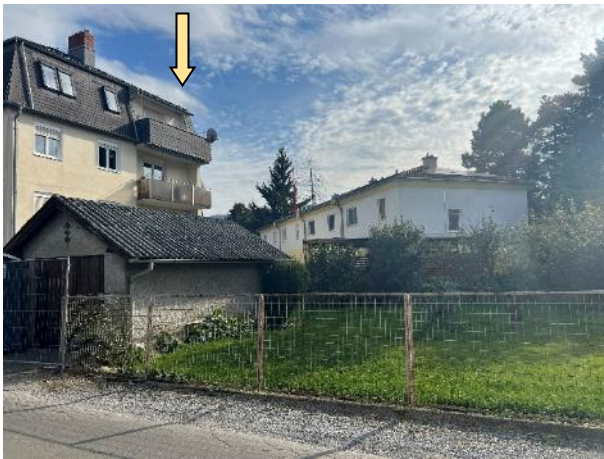
Foto 17: Blick Richtung Südosten von der Viktor-Kaplan-Gasse aus auf die Liegenschaft Viktor-Kaplan Gasse Nr. 5 lt. Pfeil.
