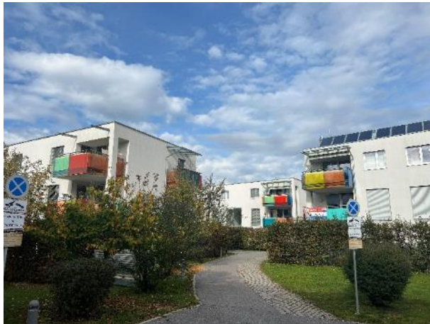
Foto 9: Blick Richtung Norden von der Grazer Straße auf die Liegenschaften Grazer Straße Nr. 23f – links im Bild und Nr. 23h – rechts im Bild.
