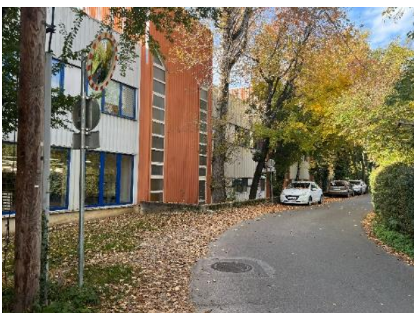
Foto 37: Blick Richtung Nordwesten von der Viktor-Kaplan-Gasse aus auf die Liegenschaft Weinzöttlstraße Nr. 16
