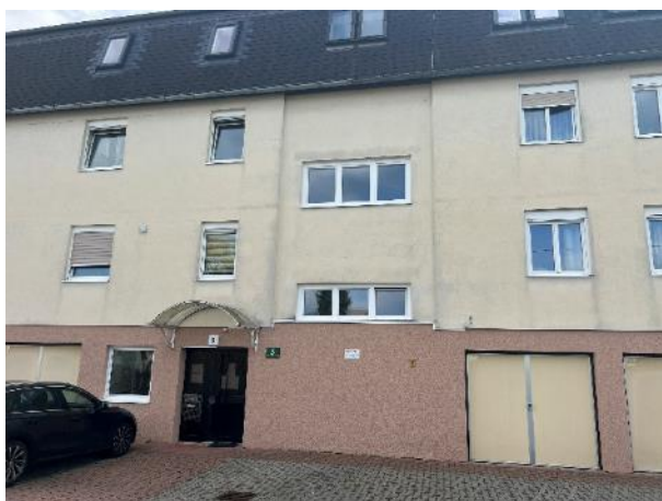
Foto 43: Blick Richtung Süden von der Viktor-Kaplan-Gasse aus auf die Liegenschaft Viktor-Kaplan-Gasse Nr. 5.
