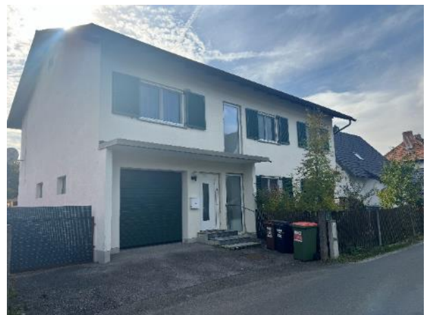
Foto 26: Blick Richtung Süden von der Viktor-Kaplan-Gasse aus auf die Liegenschaft Viktor-Kaplan Gasse Nr. 17.
