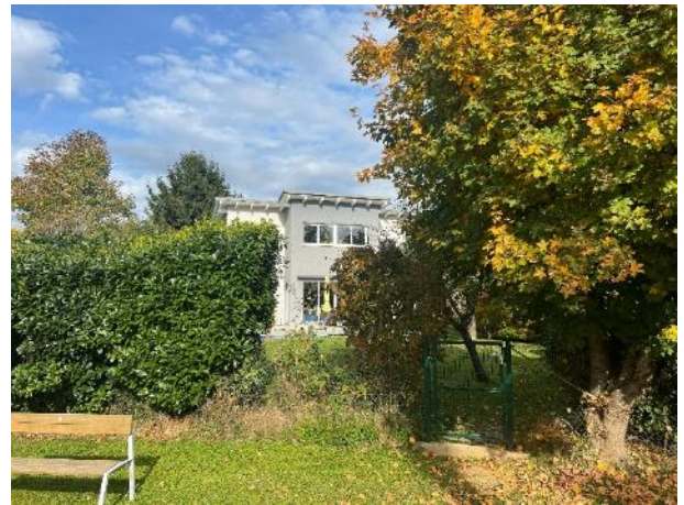
Foto 12: Blick Richtung Norden von der Wohnsiedlung an der Grazer Straße aus auf die Liegenschaft Viktor-Kaplan-Gasse Nr. 19b.
