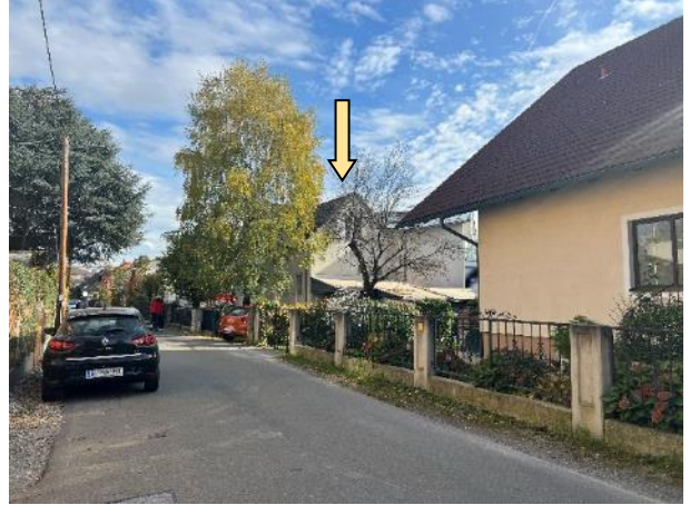
Foto 34: Blick Richtung Südosten von der Viktor-Kaplan-Gasse aus auf die Liegenschaft Viktor-Kaplan Gasse Nr. 25 lt. Pfeil.
