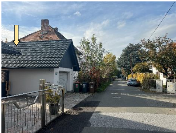
Foto 29: Blick Richtung Westen entlang der Viktor-Kaplan-Gasse aus auf die Liegenschaft Viktor-Kaplan Gasse Nr. 19 lt. Pfeil.
