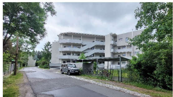
Foto 8: Blick in südliche Richtung an der Karl-Morre-Straße 92;
