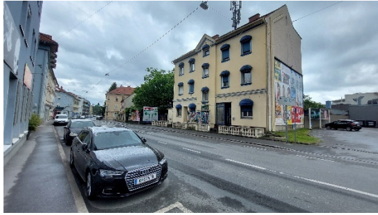
Foto 3: Blick in östliche Richtung an der Reininghausstraße 72;
