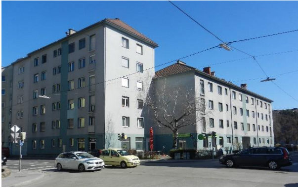
Abbildung 5: Blick vom Kreuzungsbereich Fröhlichgasse/ Kasernstraße in Richtung Osten.
