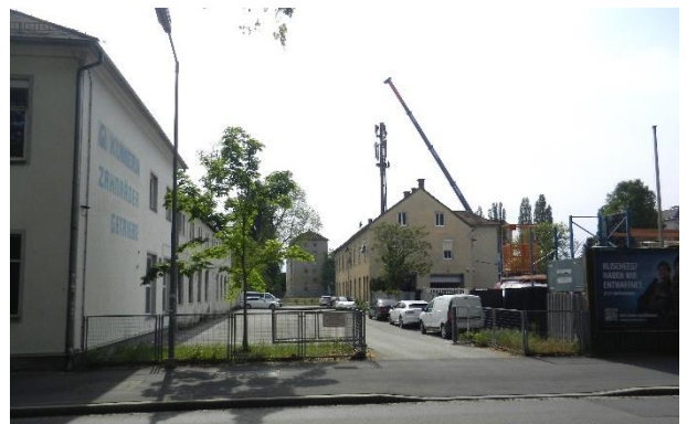
Abbildung 40: Blick von der Raiffeisenstraße Höhe Hausnummer 38 auf das Planungsgebiet in Richtung Südwesten.
