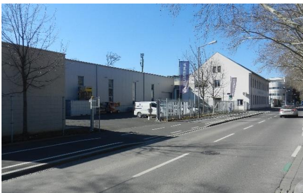
Abbildung 15: Blick auf die Bebauung Raiffeisenstraße Hausnummer 38 in Richtung Nordwesten.
