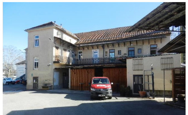
Abbildung 36: Blick vom Planungsgebiet auf das Bestandsgebäude Draisgasse 20c in Richtung Südosten.
