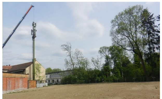
Abbildung 30: Blick vom Planungsgebiet auf die südöstlich angrenzende Bebauung in Richtung Südosten.
