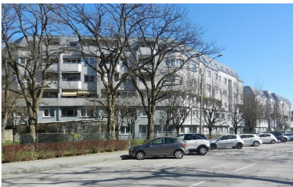
Abbildung 21: Blick vom Kreuzungsbereich Kasernstraße/ Trattenweg in Richtung Südosten.
