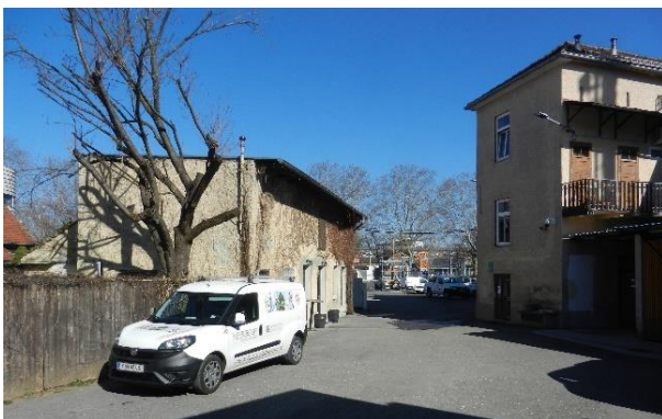
Abbildung 35: Blick vom Planungsgebiet auf die Bestandsgebäude Draisgasse 20b und 20c in Richtung Osten.
