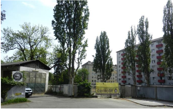
Abbildung 25: Blick von der Kreuzung Pomisgasse/Draisgasse auf das Planungsgebiet in Richtung Süden.
