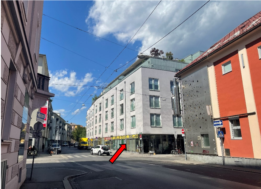
Foto 2: Idlhofgasse – Kreuzung Prankergasse: Blick Richtung Norden; Roter Pfeil zeigt auf das Wohn- und Geschäftshaus Idlhofgasse 33, 37 – Prankergasse 24
