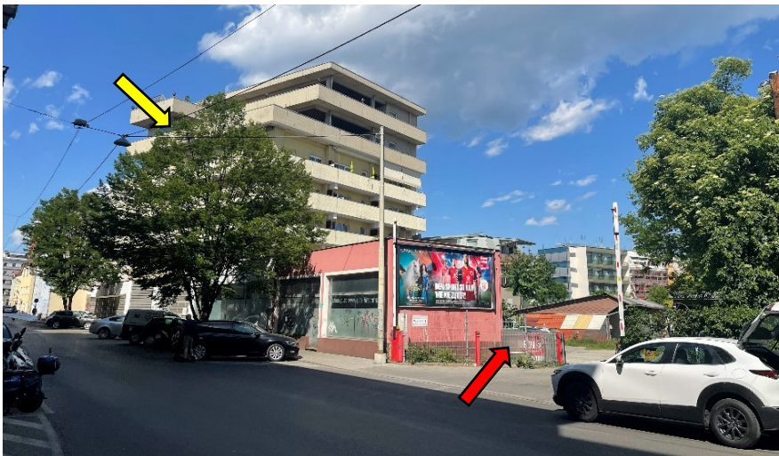
Foto 3: Idlhofgasse: Blick Richtung Nordosten: Roter Pfeil zeigt die Zufahrt zum Areal ehemalige Destillerie Bauer; gelber Pfeil zeigt auf solitäre Gebäude Idlhofgasse 17 mit 7 Geschossen v
