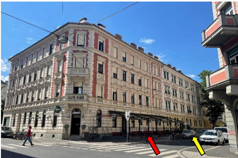
Foto 5: Kreuzungsbereich Ungergasse / Kindermannngasse, Eckhaus Ungergasse 18 / Kindermannngasse 16 (roter Pfeil), Kindermannngasse 14 (gelber Pfeil) Blick Richtung Nordwesten
